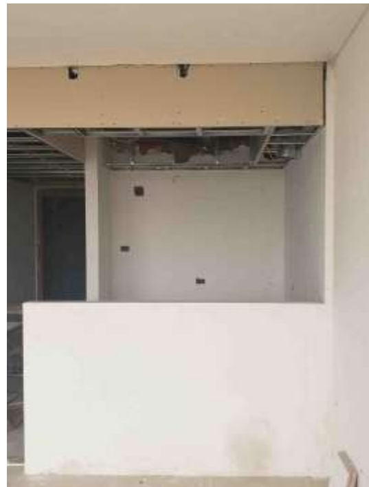
Torre Arcos – Estructura Durlock
