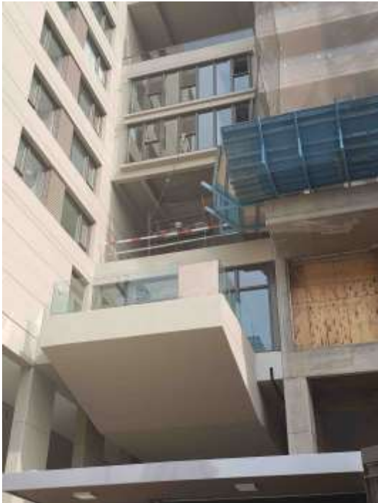
Puentes – Piso 1º. Baranda Pileta Exterior
