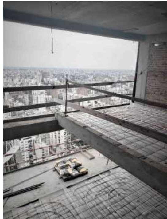
Torre Arcos – Pisos 33/34°. Piso Radiante
