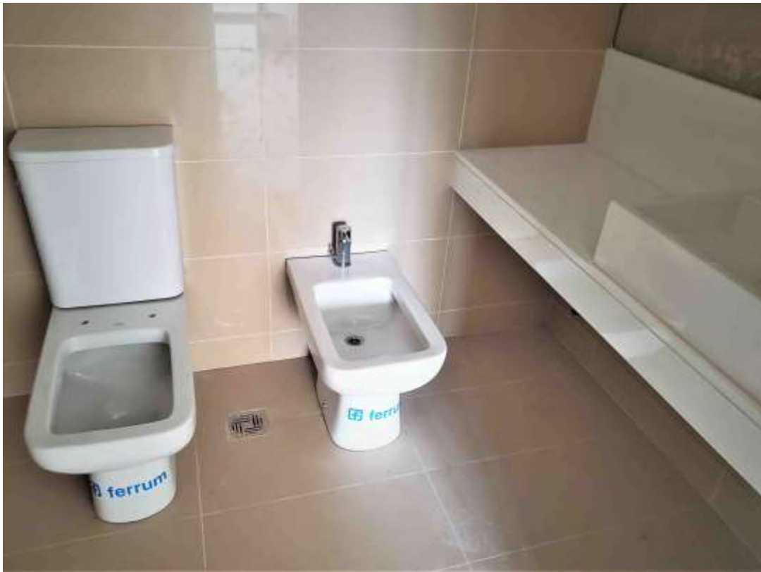
Torre Arcos – Piso 5°. Instalación Artefactos Sanitarios
