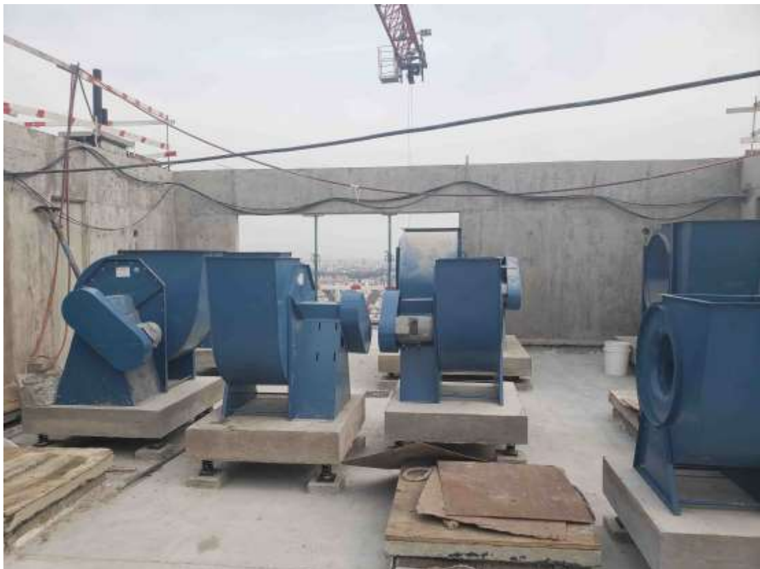
Torre Arcos – Piso 35°. Montaje de Ventiladores
