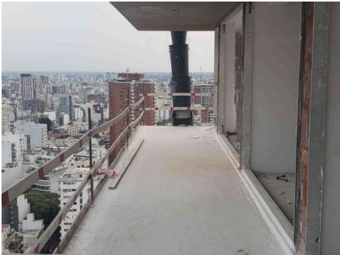
Torre Arcos – Piso 28°. Aislación en Balcones
