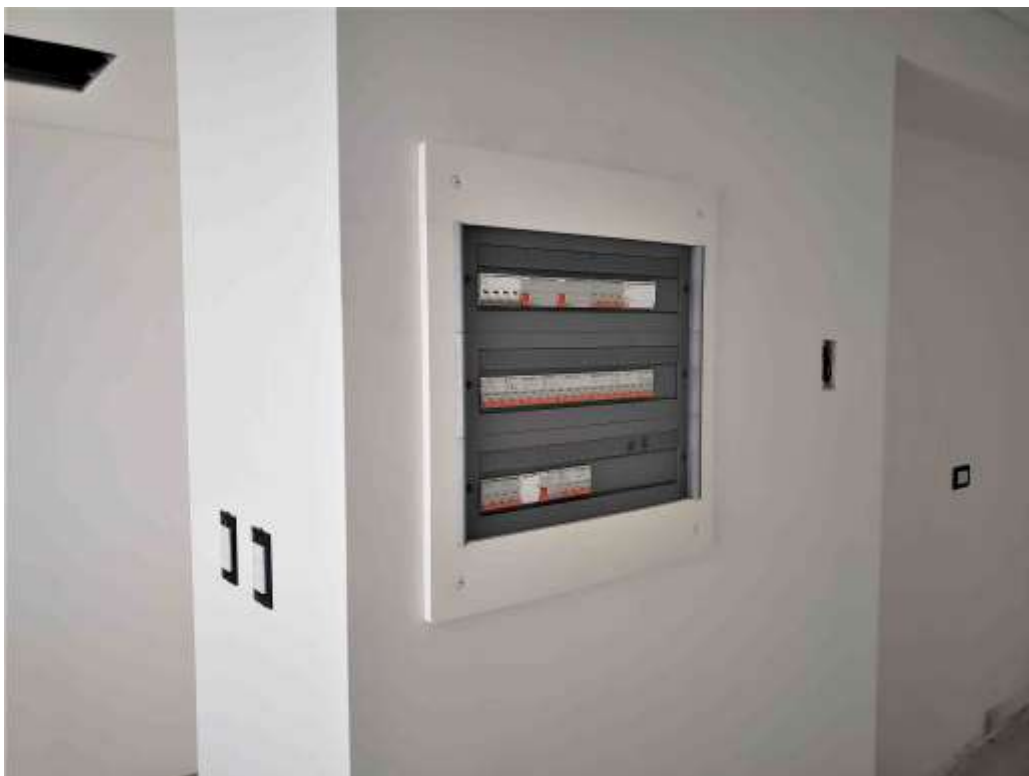
Torre Arcos – Piso 5°. Armado Tableros Eléctricos
