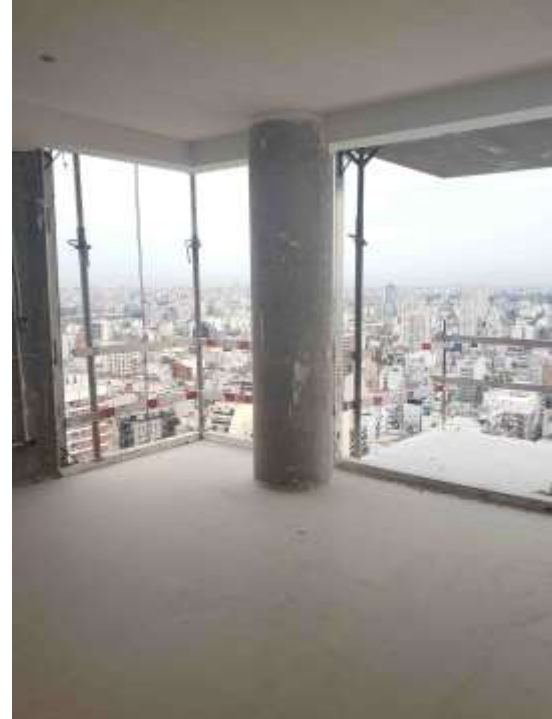
Torre Arcos – Piso 28°. Colocación Solado
