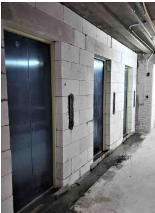
Torre Arcos – Frente Ascensores
