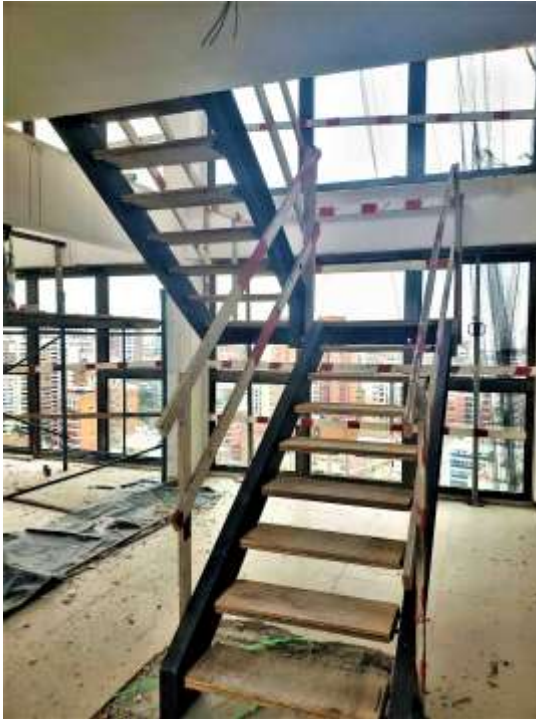
Torre Arcos – Piso 20°. Escalera Dúplex
