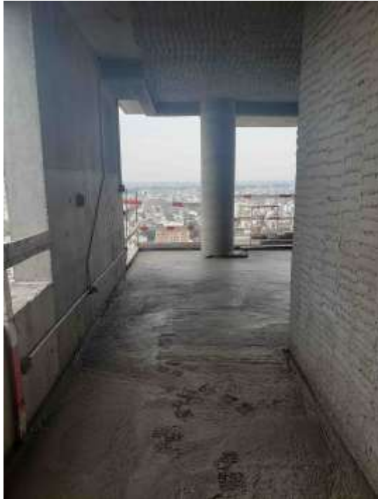
Torre Arcos – Piso 32°. Contrapisos
