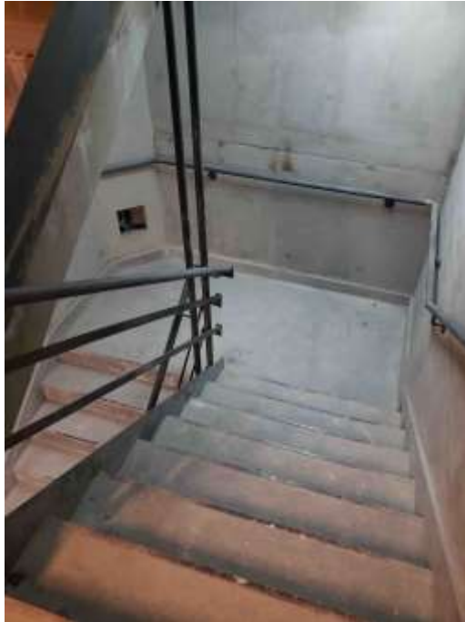
T. Arcos – Baranda Escalera Piso 9°.
