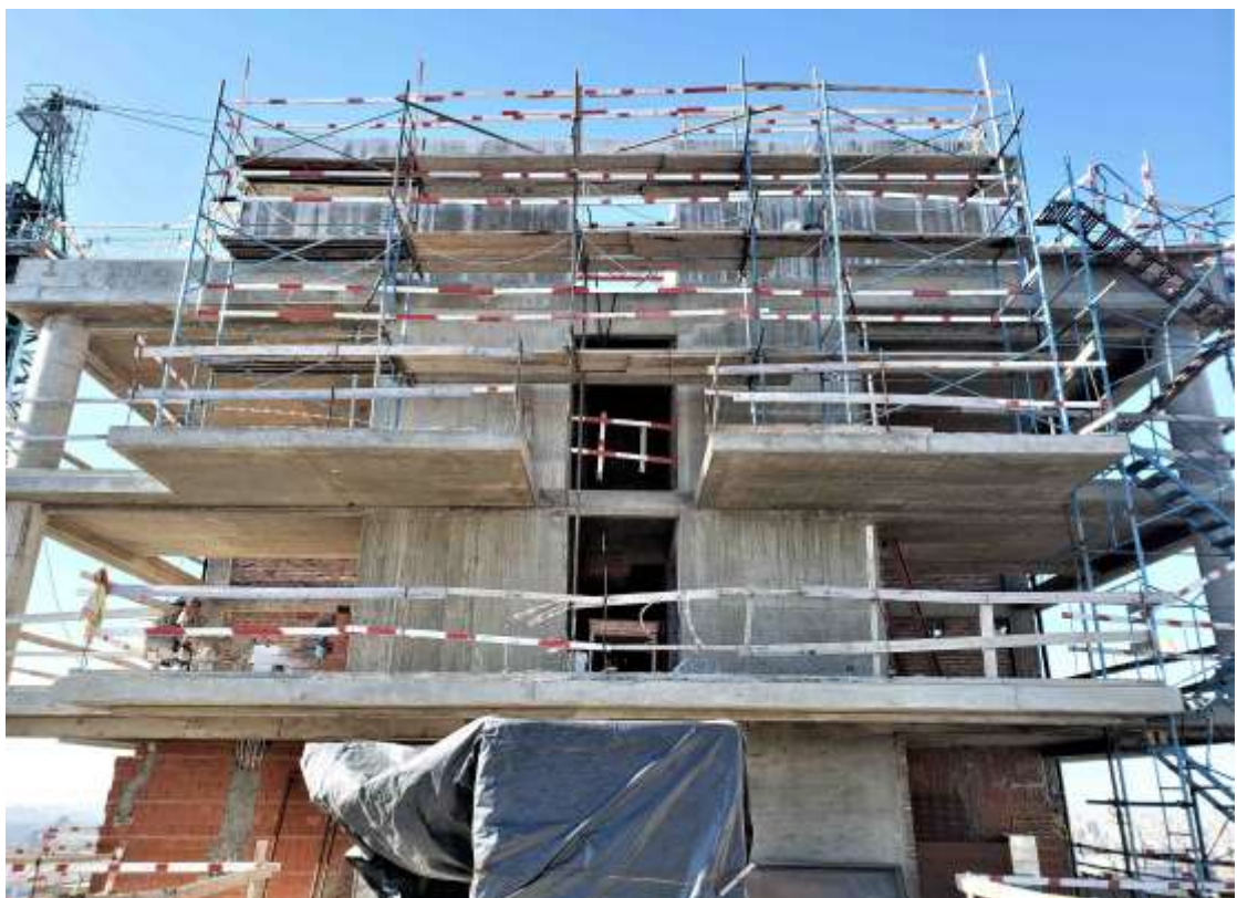
Torre Arcos – Emprolijado Exterior de Ho. Ao. Piso 32º.
