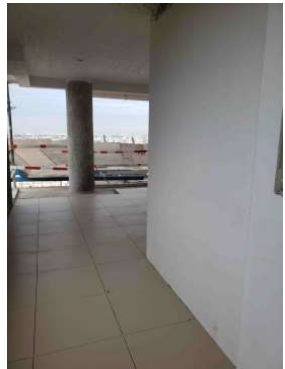
T. Arcos – Colocación solados Piso 26°.
