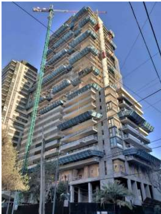
Torre Arcos – Vista Loreto
