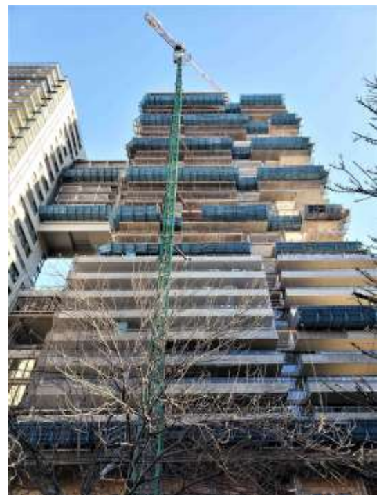
Torre Arcos – Vista Arcos
