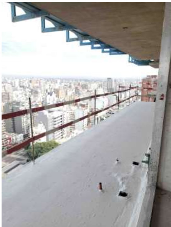
T. Arcos – Aislación Balcones Piso 25°.
