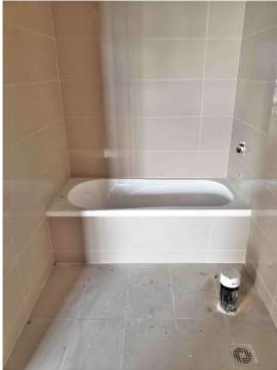
T. Arcos – Pisos y Revest. Baño Piso 16°.
