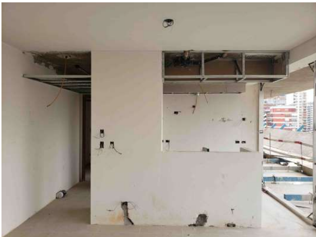
Torre Arcos – Estructura Durlock Piso 11°.
