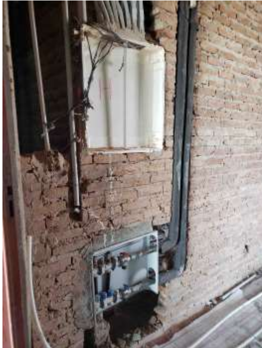
T. Arcos – Cañería hierro negro Piso 32º.
