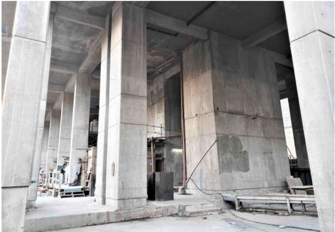
Torre Arcos – Sector Planta Baja
