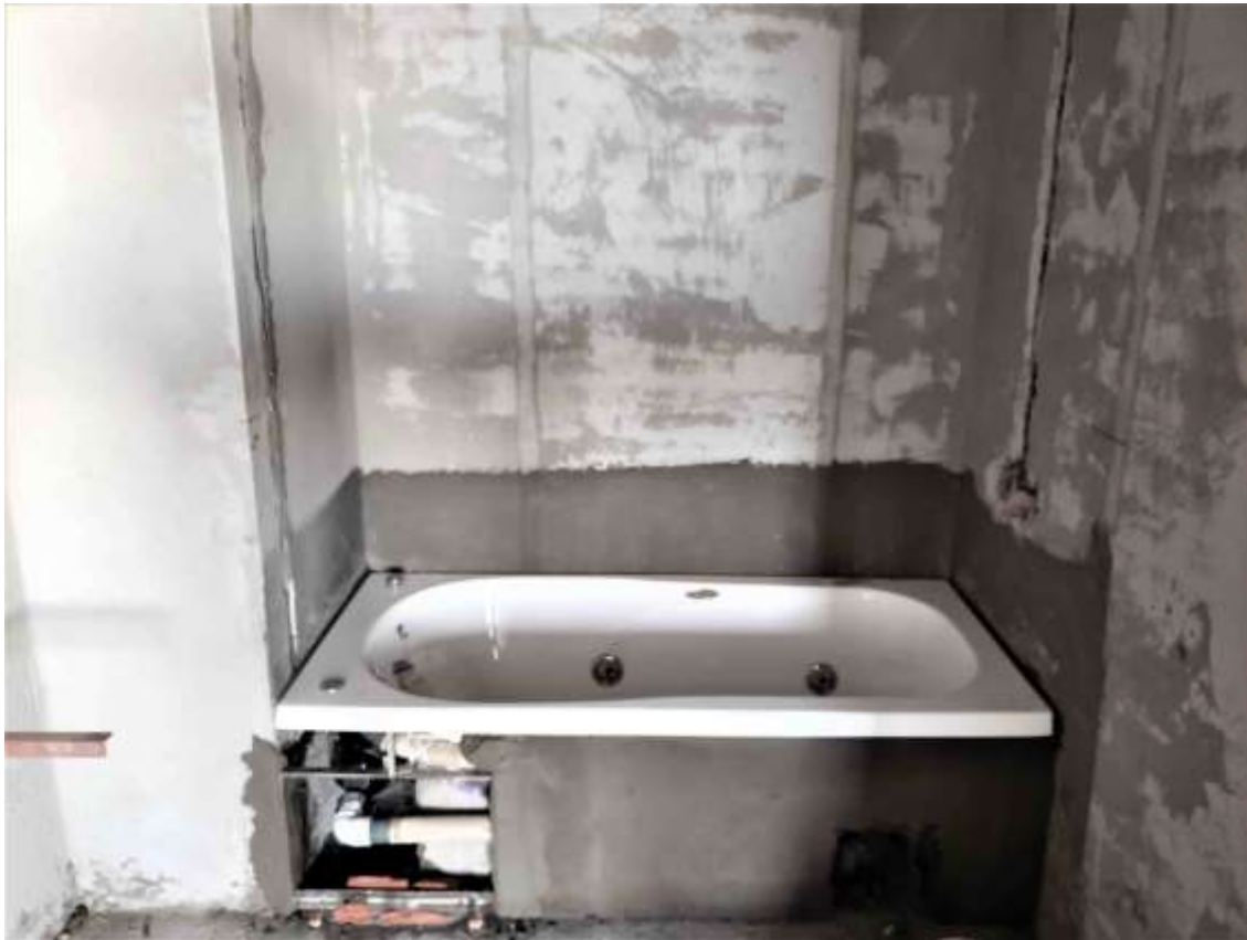
Torre Arcos – Piso 18°. – Colocación Bañeras
