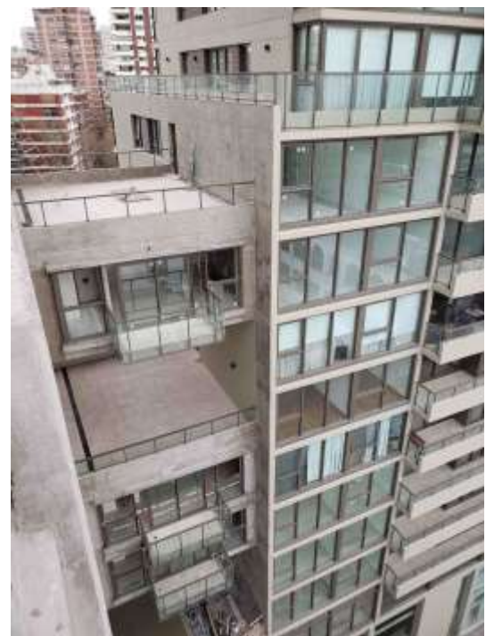
Torre Arcos – Contrafrente Pisos Bajos
