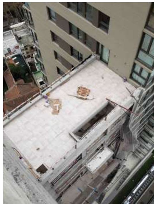
Torre Arcos – 22°P – Colocación Piso
