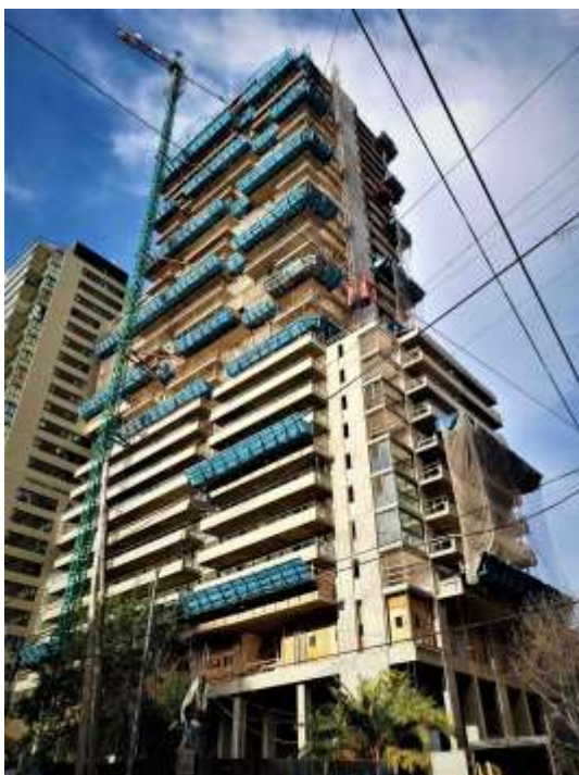
Torre Arcos – Vista Loreto
