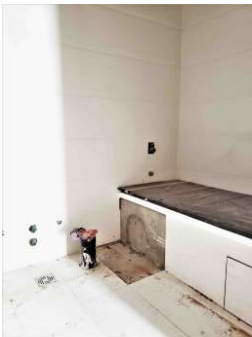
T. Arcos – 16°.P - Revestimientos
