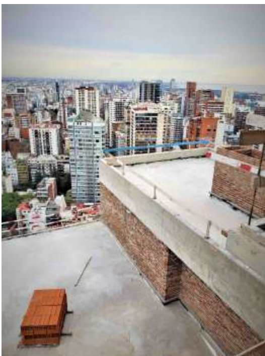
Torre Arcos – Contrapiso Terrazas
