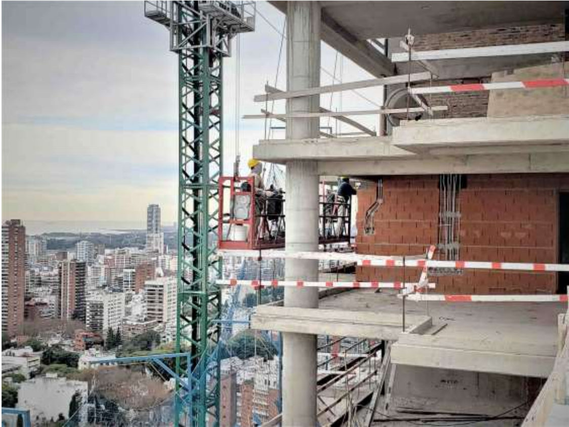
Torre Arcos – Piso 33°. Emprolijado Estructura Ho.Ao.
