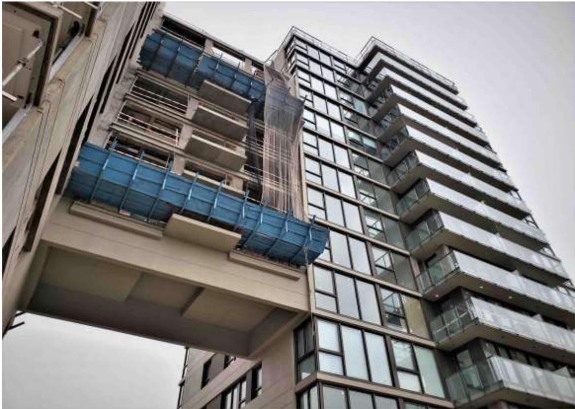
Torre Arcos – Contrafrente Pisos Altos
