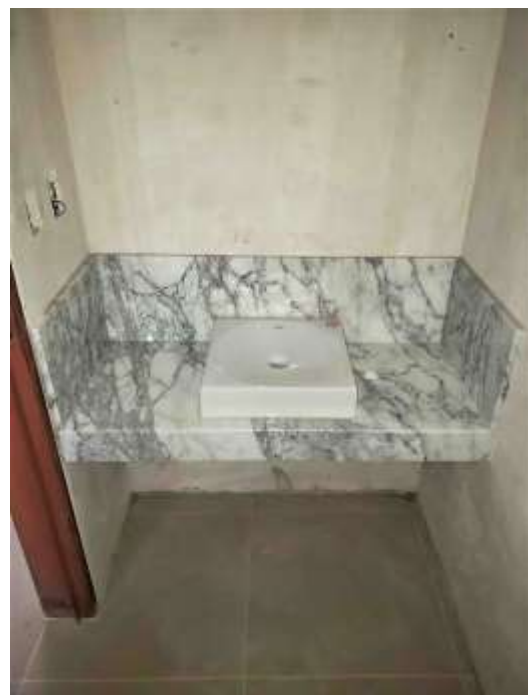
Torre Arcos – 9°.P – Mesadas y Bachas
