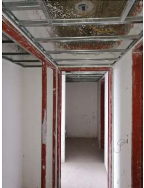
Torre Arcos – Estructura Cielorrasos 10º.P
