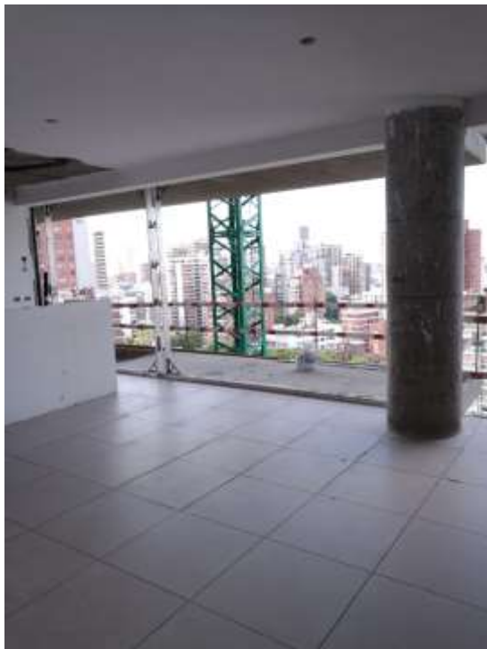
Torre Arcos – Colocación Piso 17°.
