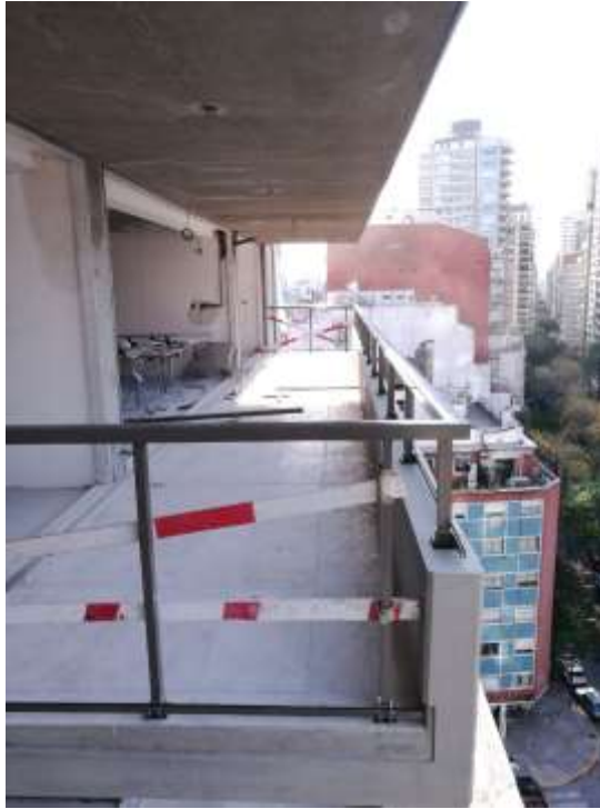
Torre Arcos – Barandas Piso 9°.
