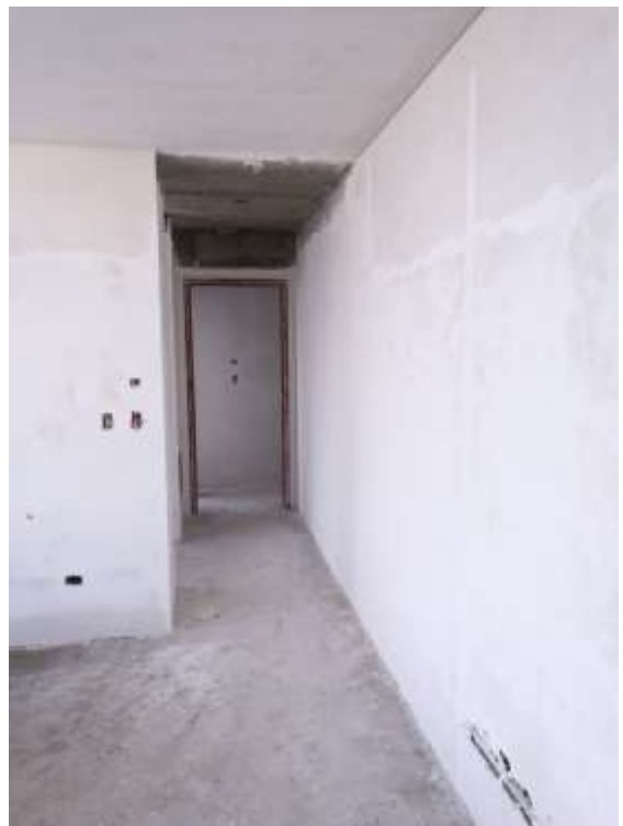
Torre Arcos – Yeso Piso 23º.
