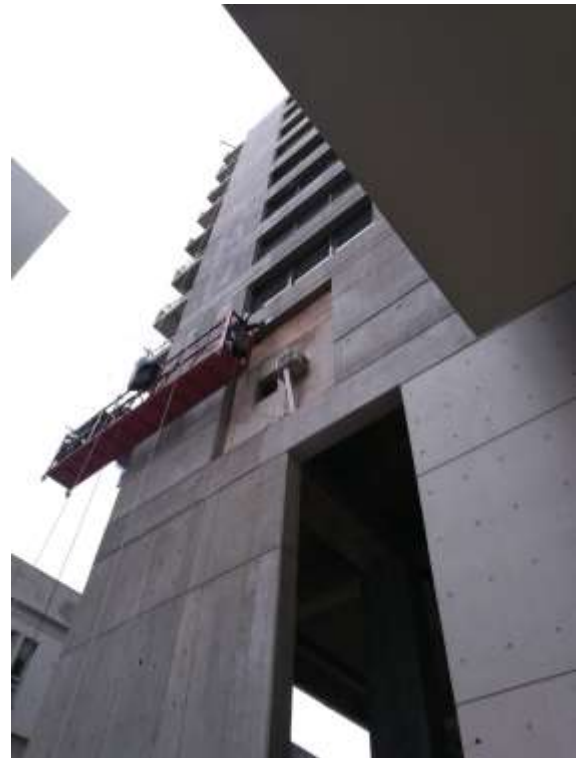
Torre Arcos – Tratamiento Fachada
