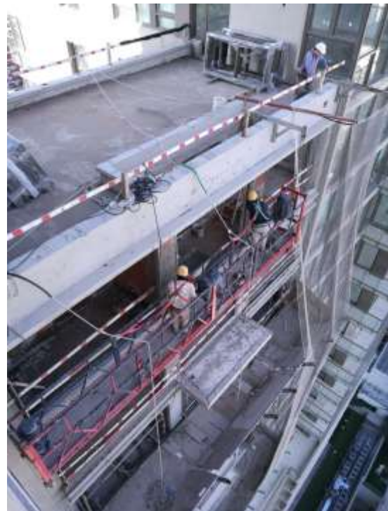
Torre Arcos – Contrapiso Puentes
