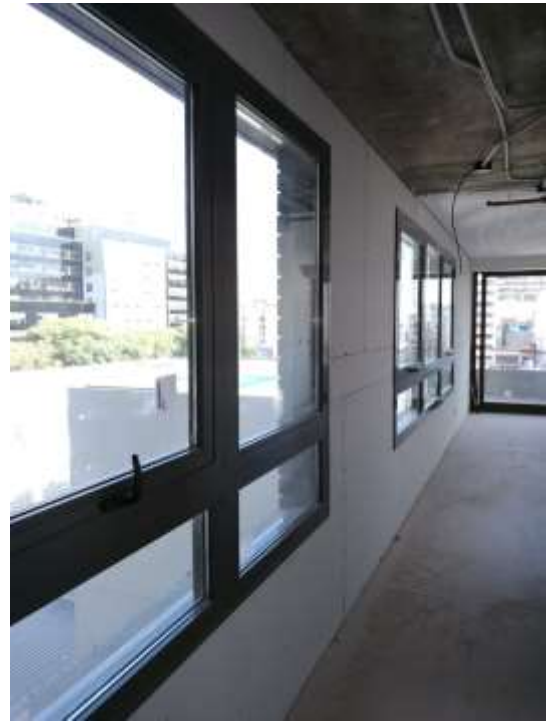
Torre Arcos – Carpinterías Piso 5°
