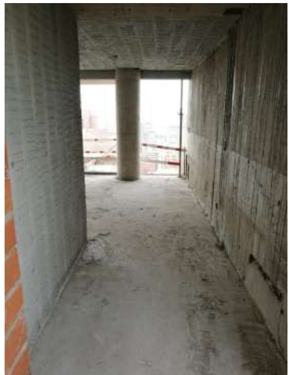
Torre Arcos – Piso 22º. Contrapiso Interior
