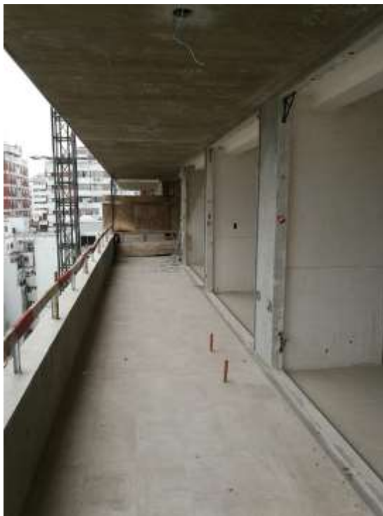
Torre Arcos – Piso 9º. Solado Balcones
