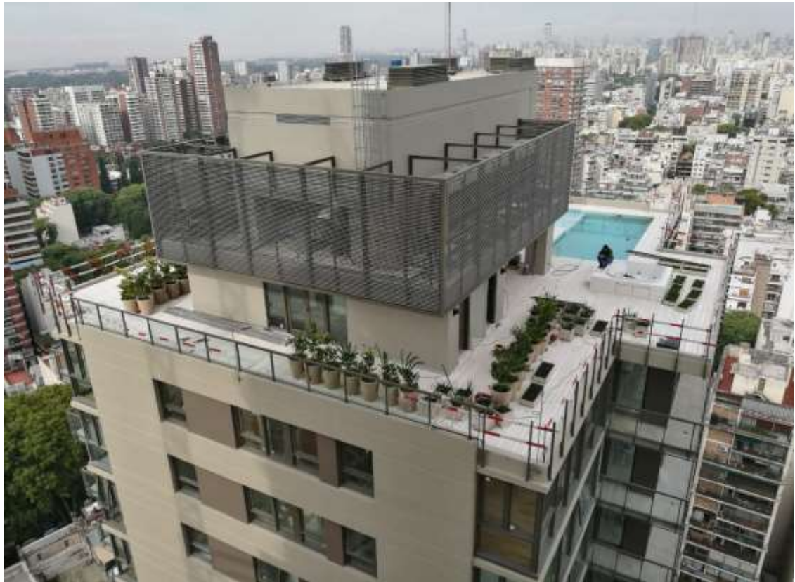
Torre Zabala – Vista Aérea Remate Edificio
