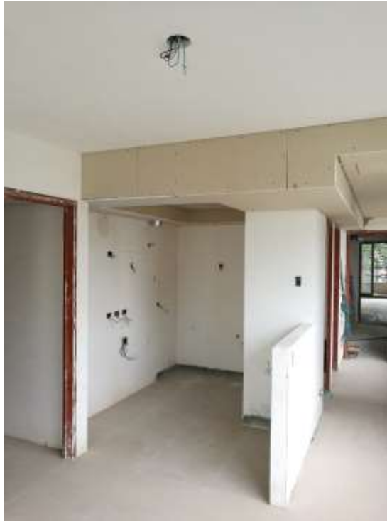
Torre Arcos – Piso 5º. Emplacado Durlock
