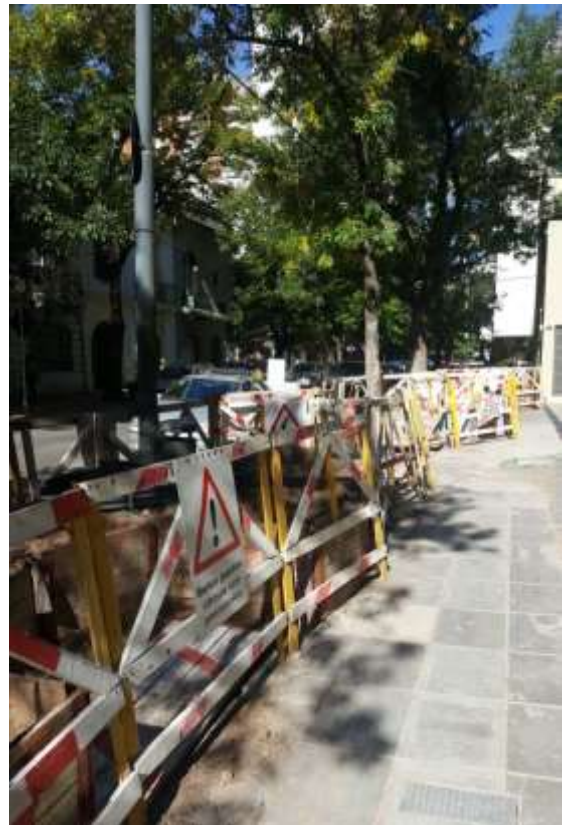
Trabajos de Edenor en Vereda Arcos
