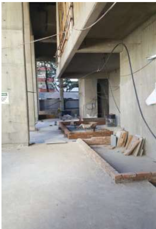
Torre Arcos – P. Baja Contrapisos
