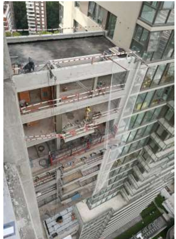
Torre Arcos – Puentes – Prolijado Ho.Ao.
