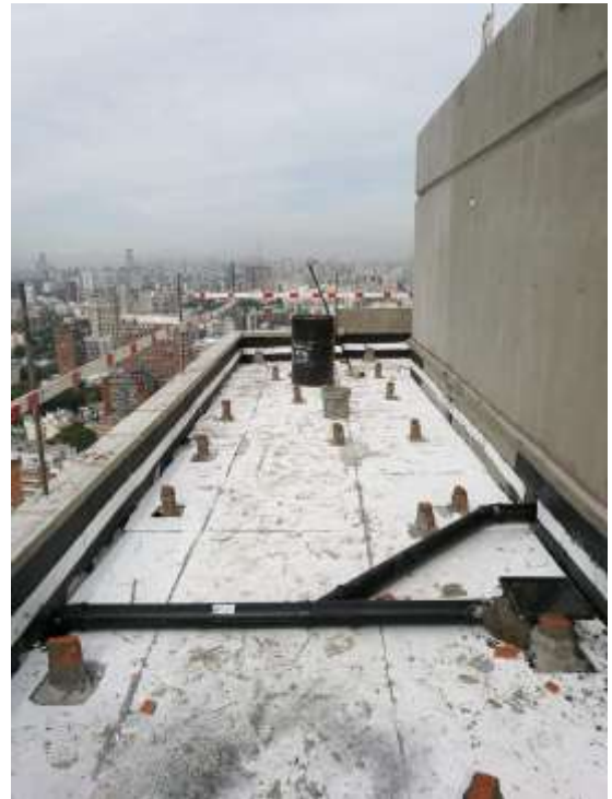
T.Arcos – Piso 35°. Aislación y Desagües
