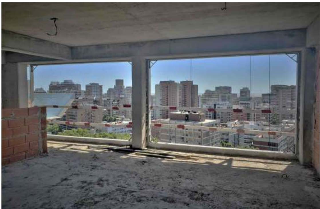
Torre Arcos – Piso 18°. Puente - Amure Premarcos
