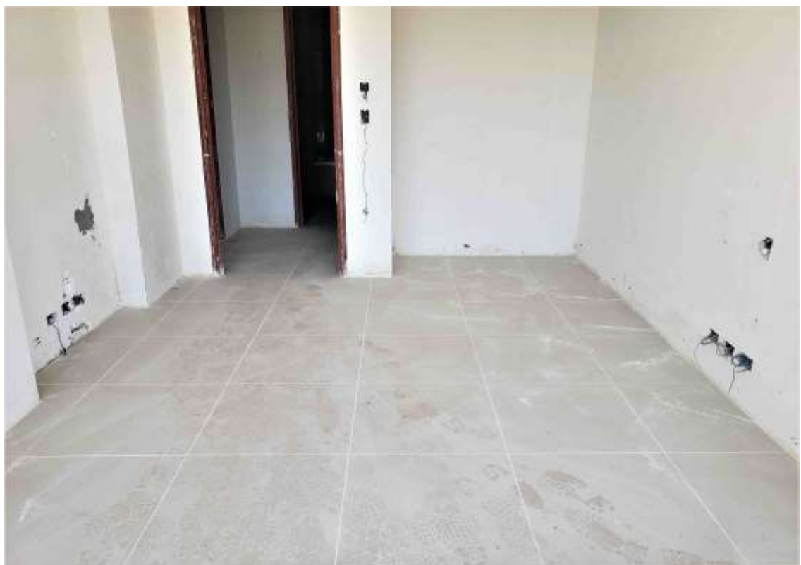
Torre Arcos – Piso 10°. Colocación Solados en Departamentos
