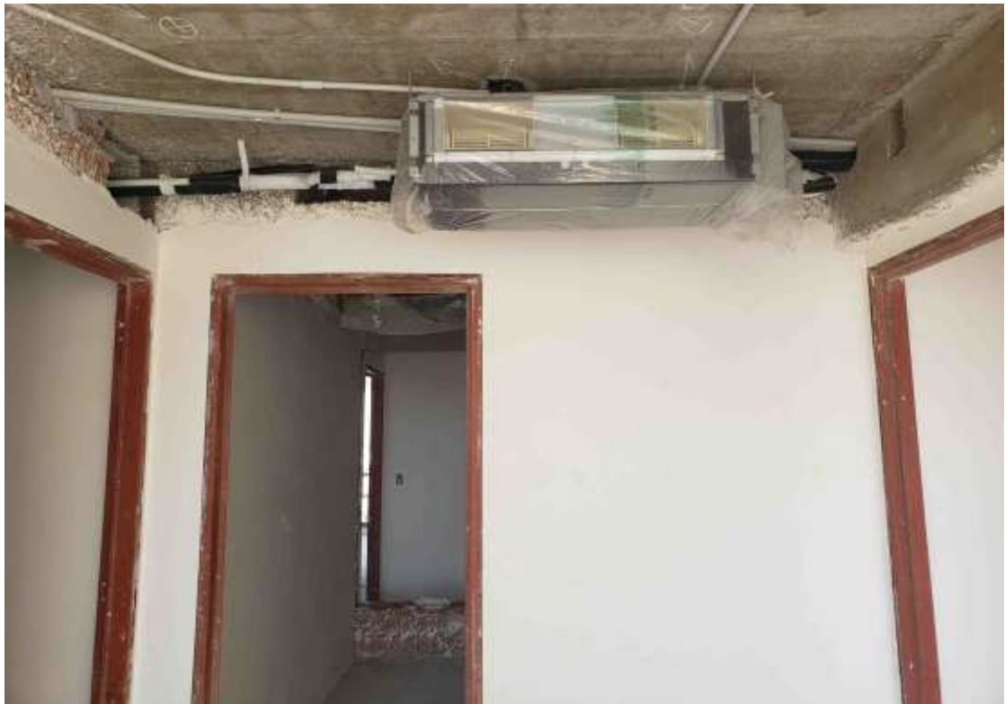
Torre Arcos – Piso 15°. – Instalación VRV
