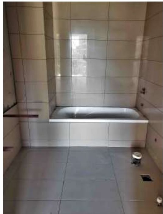
Torre Arcos – Piso 10°. Colocación Baño
