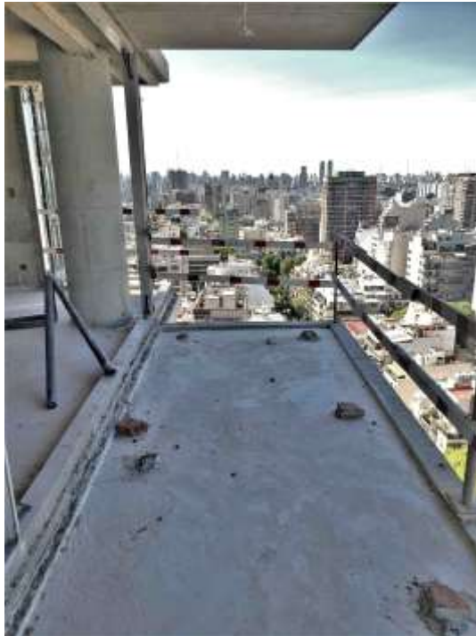
Torre Arcos – Piso 21º. Balcones
