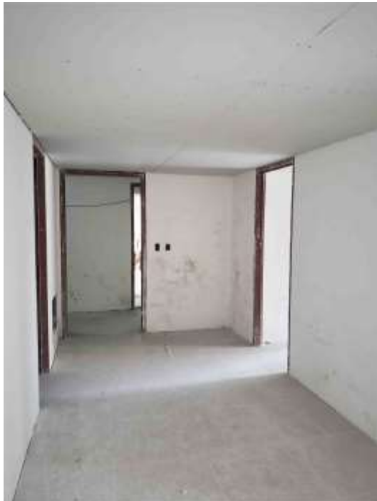
Torre Arcos – Piso 5°.Emplacado
