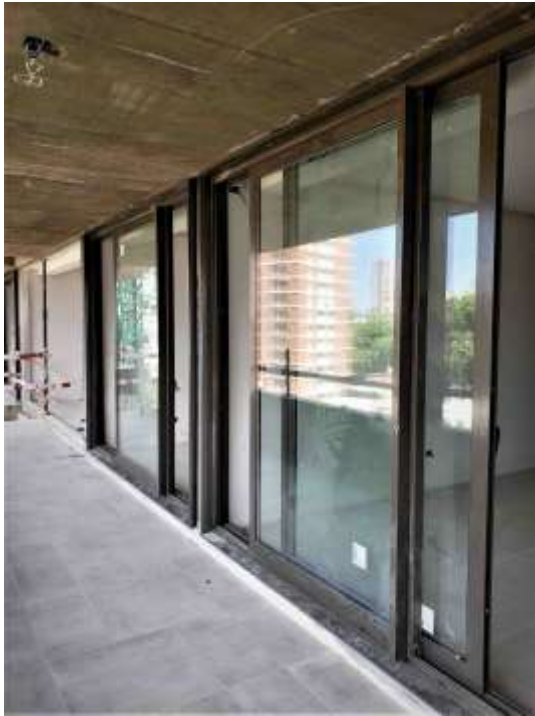
Torre Arcos – Piso 5°. Carpinterías
