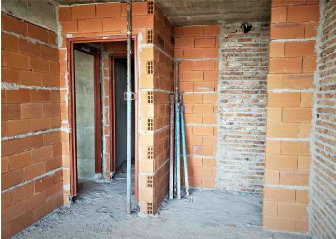
Torre Arcos – Piso 31°. Mampostería y Amure de Marcos
