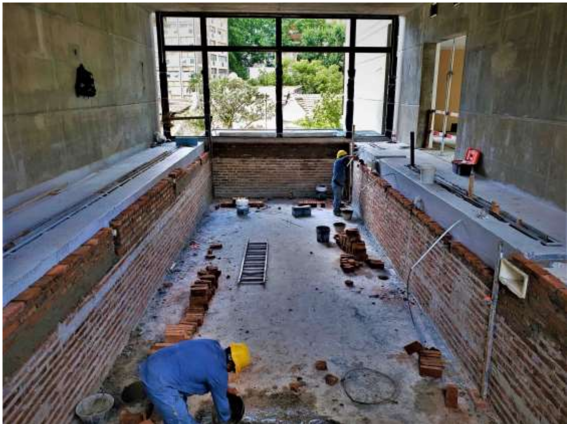
Torre Zabala – Piso 1°. Albañilería Pileta
