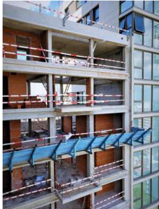
Puentes Altos - Mampostería
