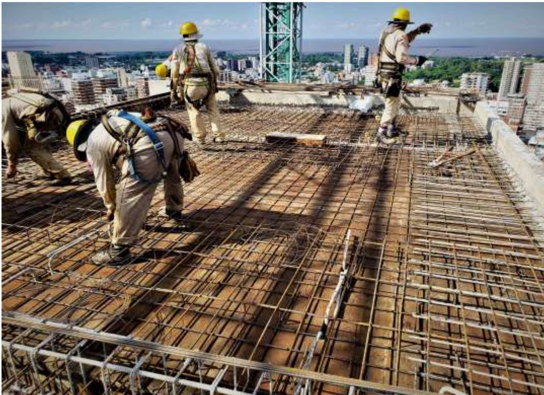
Torre Arcos – Encofrado Losa s/Piso 35°.
