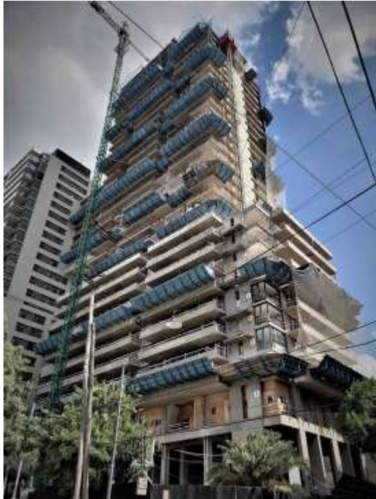
Torre Arcos – Vista Loreto
