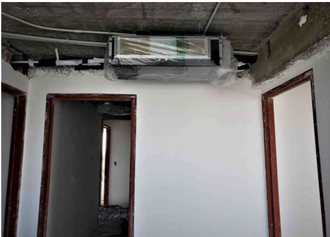
Torre Arcos – Piso 5°. Instalación VRV
