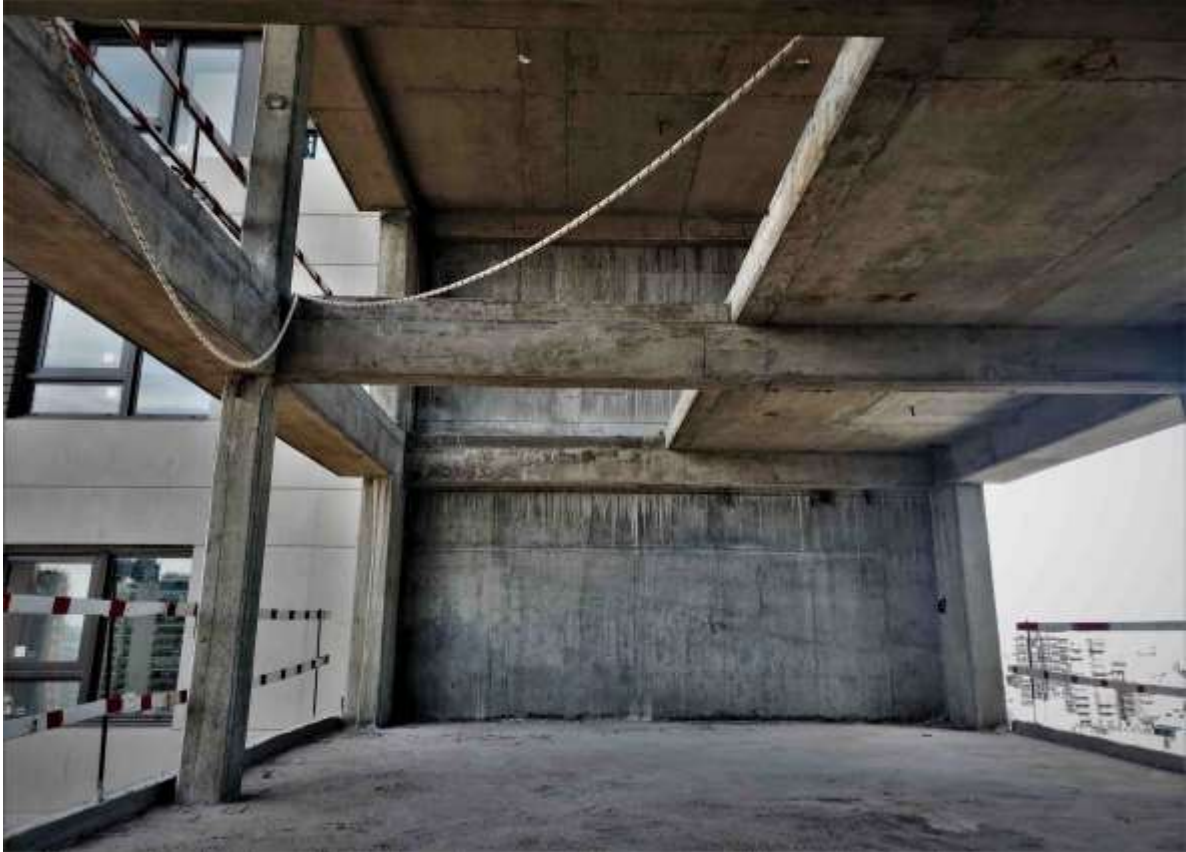
Torre Arcos – 20º.P Hormigón Puente
