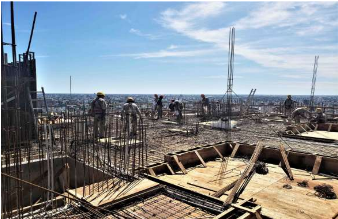
Torre Arcos – Encofrado sobre 33°P
