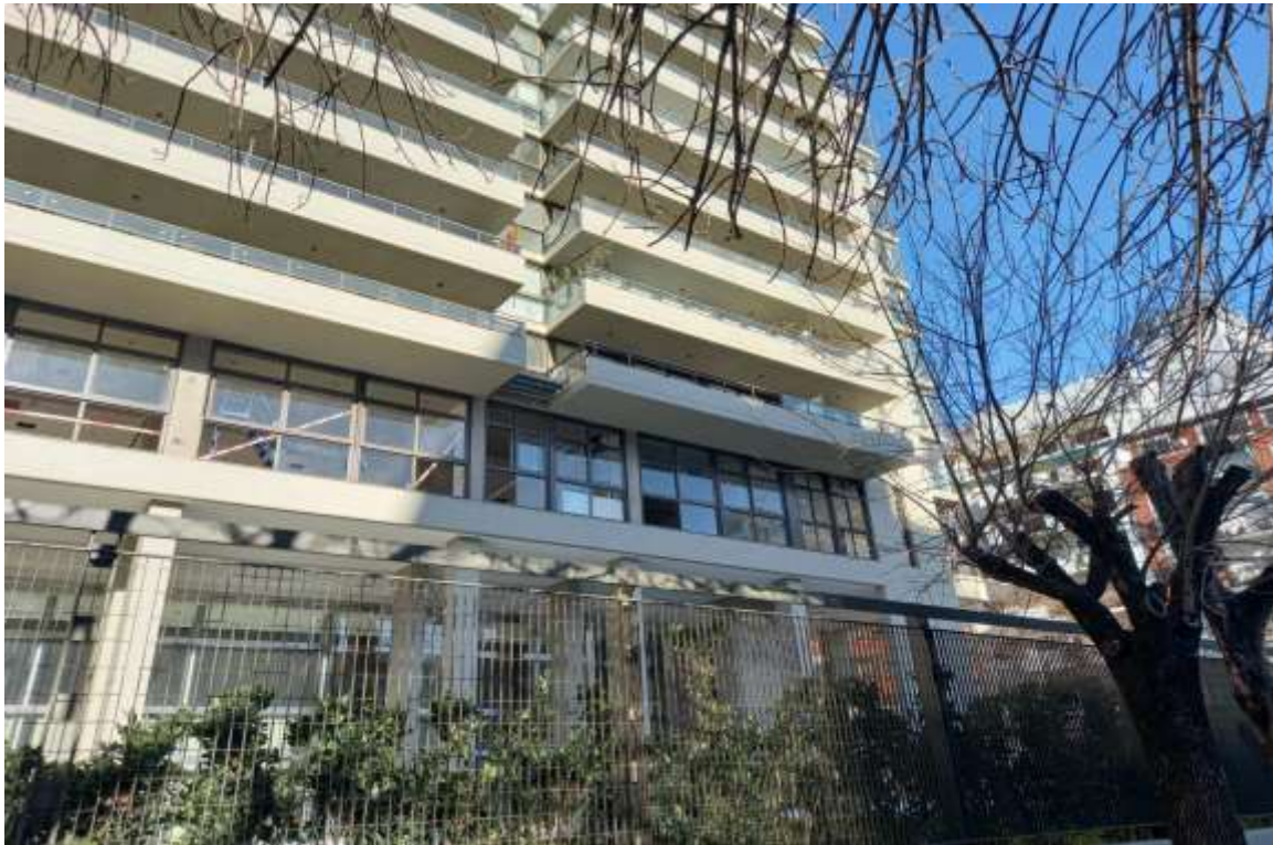
Primer Piso – Vista Carpintería Calle Arcos
