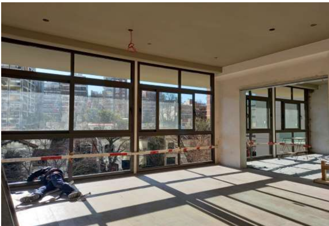
Primer Piso – Carpintería Salón Eventos
