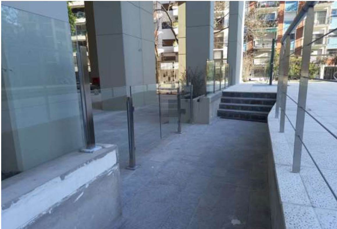
Planta Baja – Acceso a Piletas
