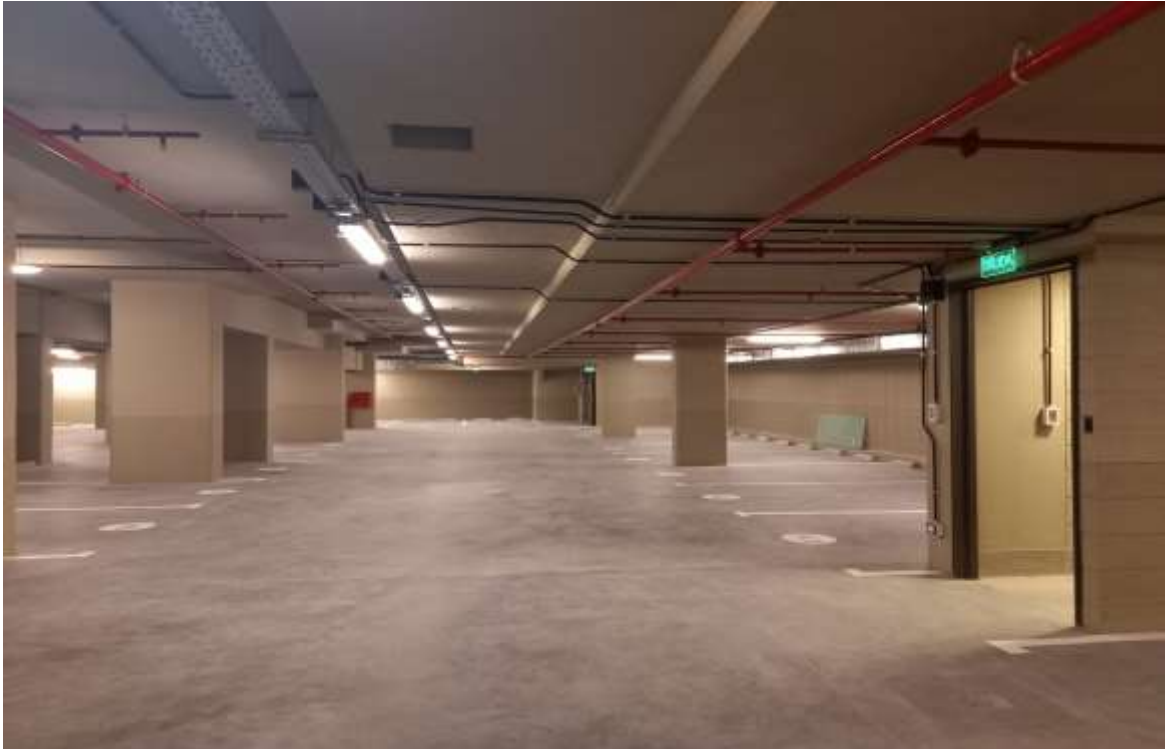
Primer Subsuelo – Demarcación Cocheras
