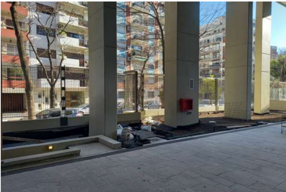
Retiro Cerco de Obra sobre Virrey Loreto
