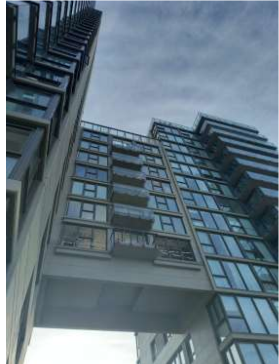
Piso 15° - Retiro Defensas Puentes
