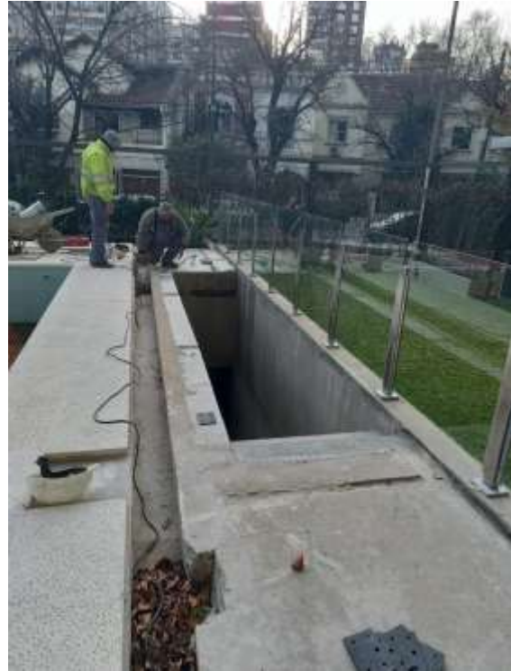
Planta Baja – Ejecución Barandas Pileta
