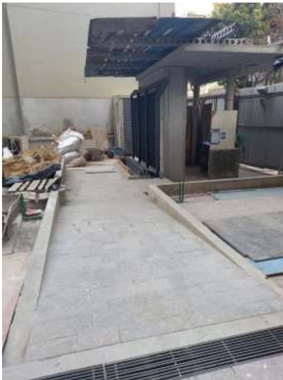
Planta Baja – Pórfido en Circulación
