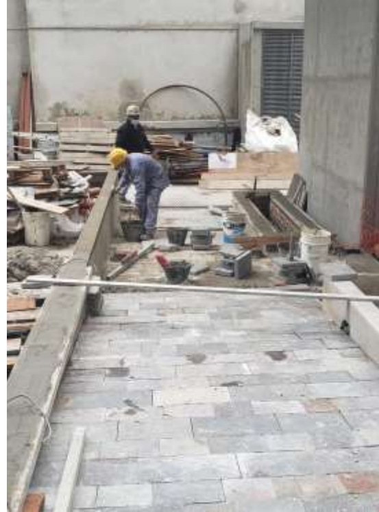
P. Baja – Colocación Pórfido
