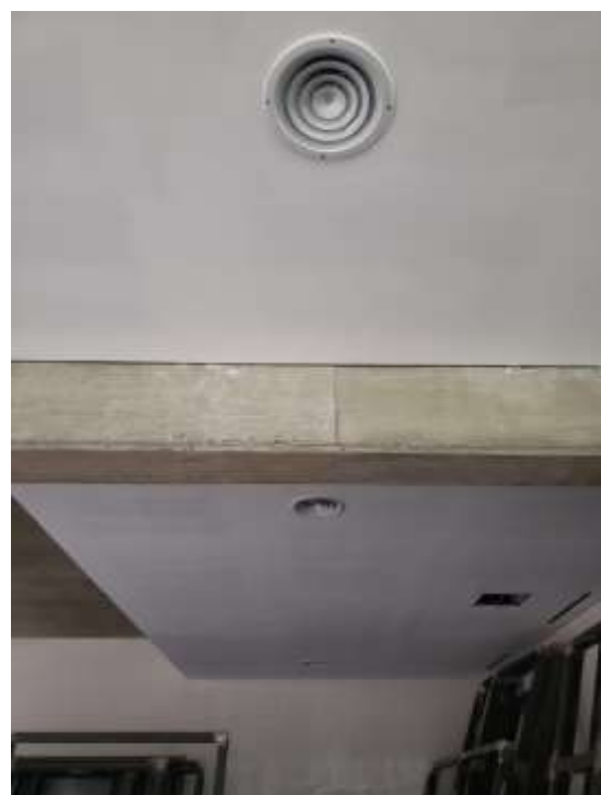
Piso 1°. Rejas de Ventilación
