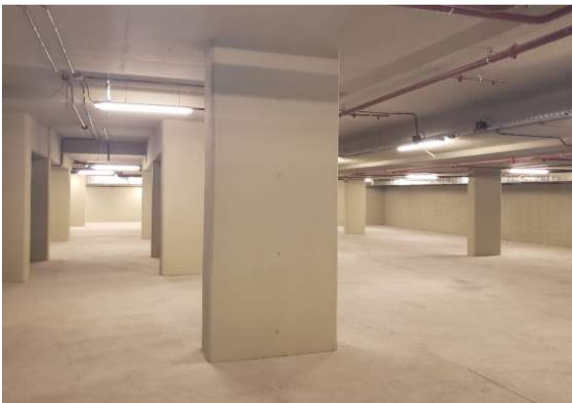
Primer Subsuelo – Pintura General
