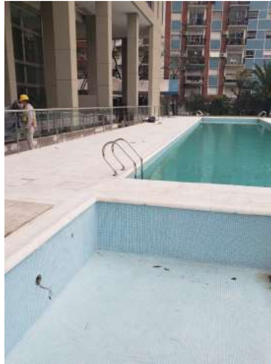
P. Baja – Revestimiento Pileta Chica
