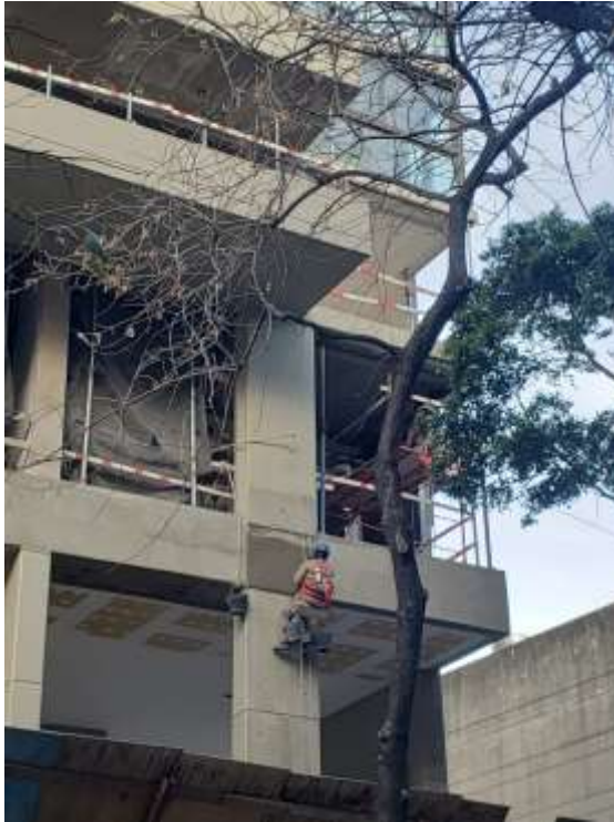
Tratamiento Exterior Ho.Ao.
