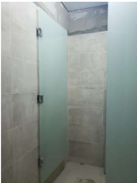
Piso 1°. Colocación de Mamparas
