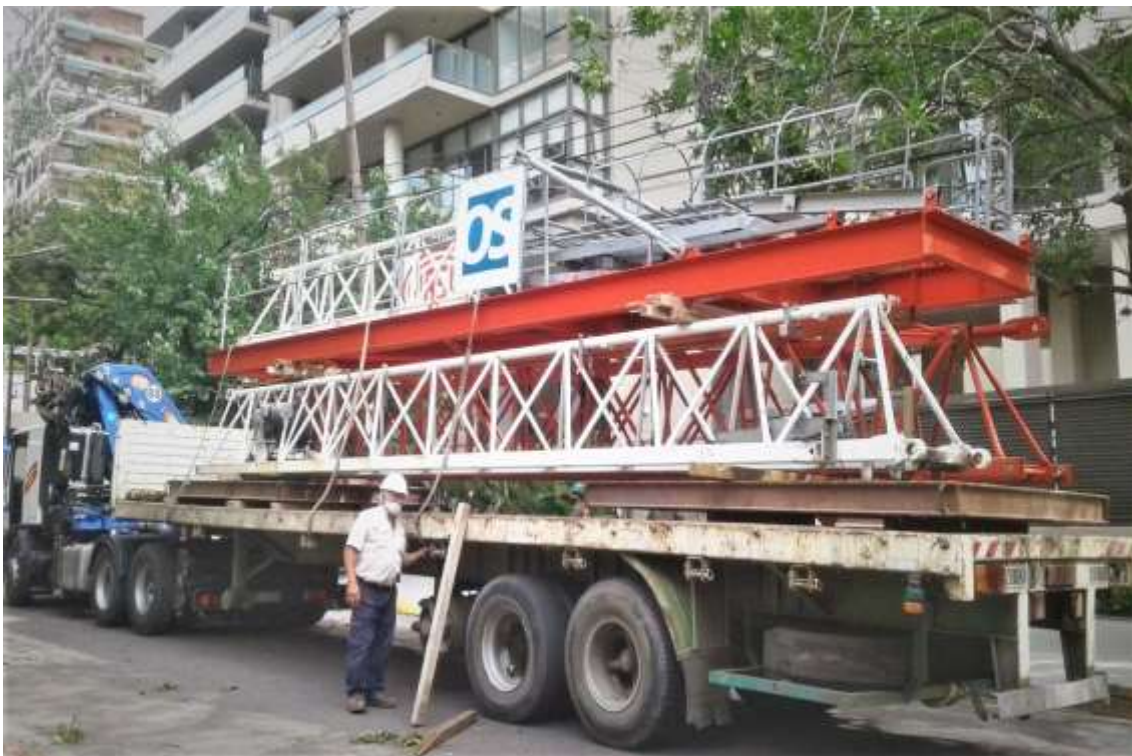
Retiro Torre Grúa
