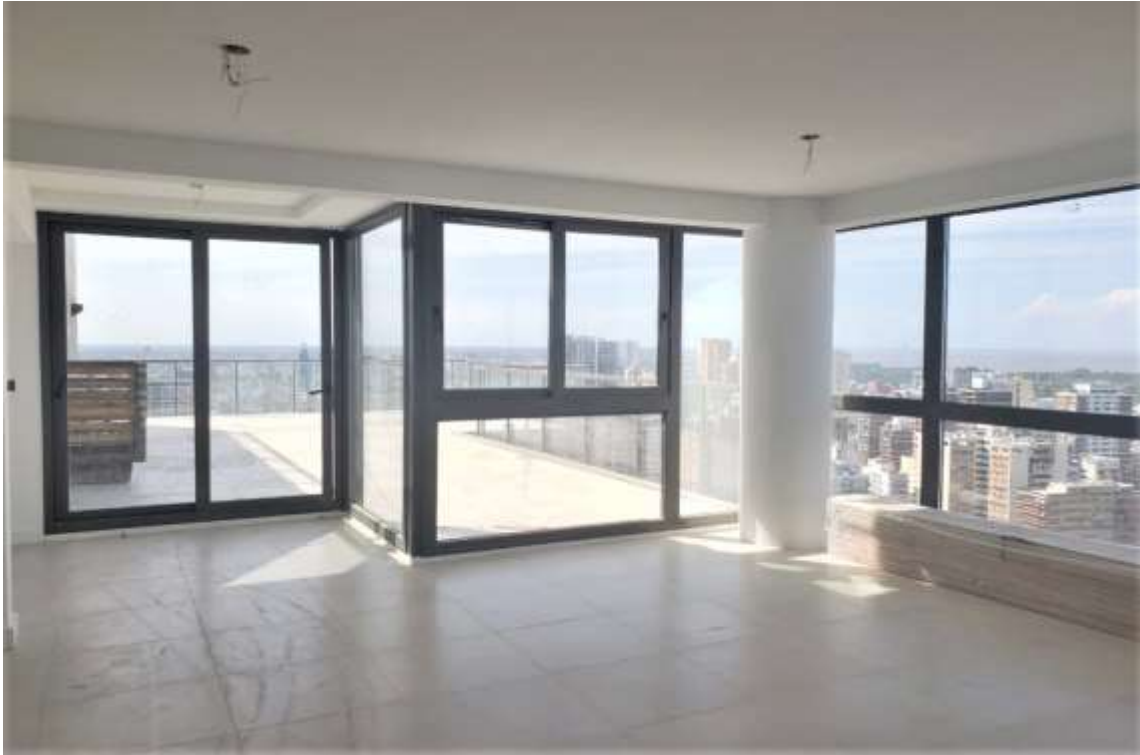
Piso 31°. Carpinterías Exteriores
