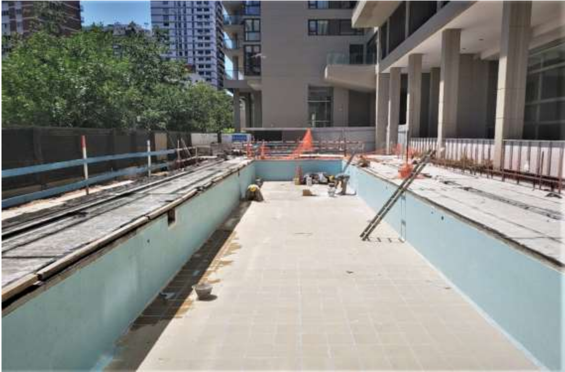
Planta Baja – Revestimiento y Solado Pileta
