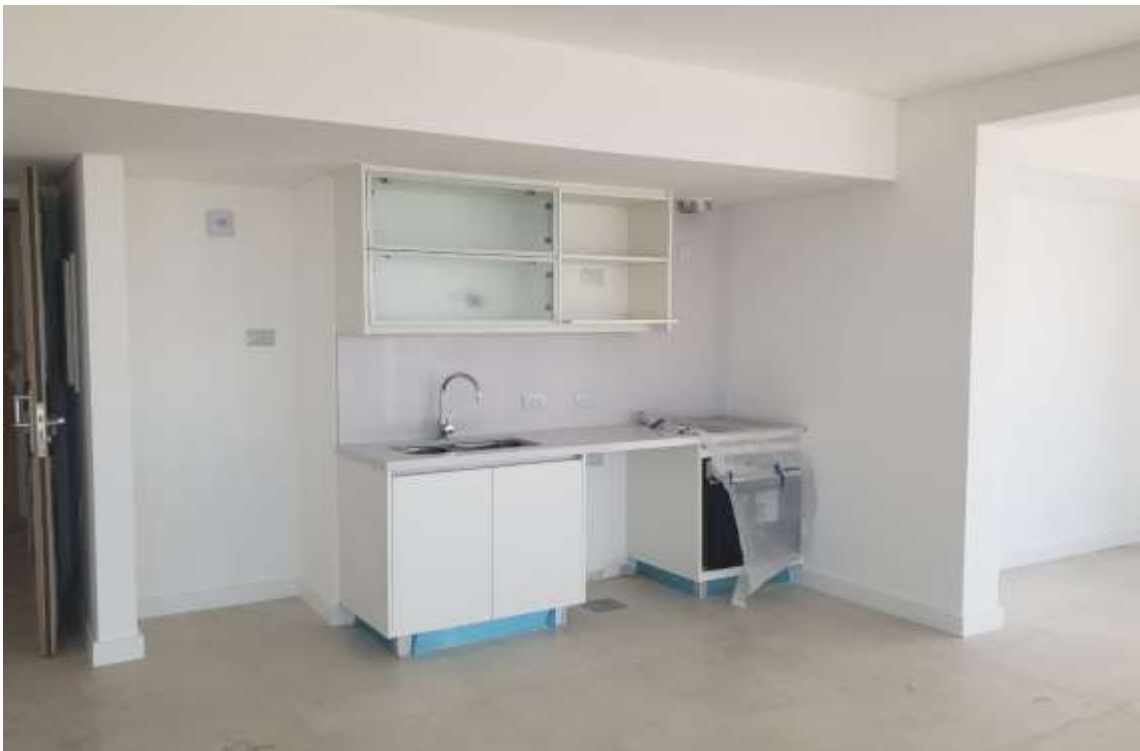
Piso 31°. Mobiliario Cocina
