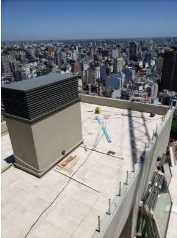
Piso 32º. Insertos de Barandas
