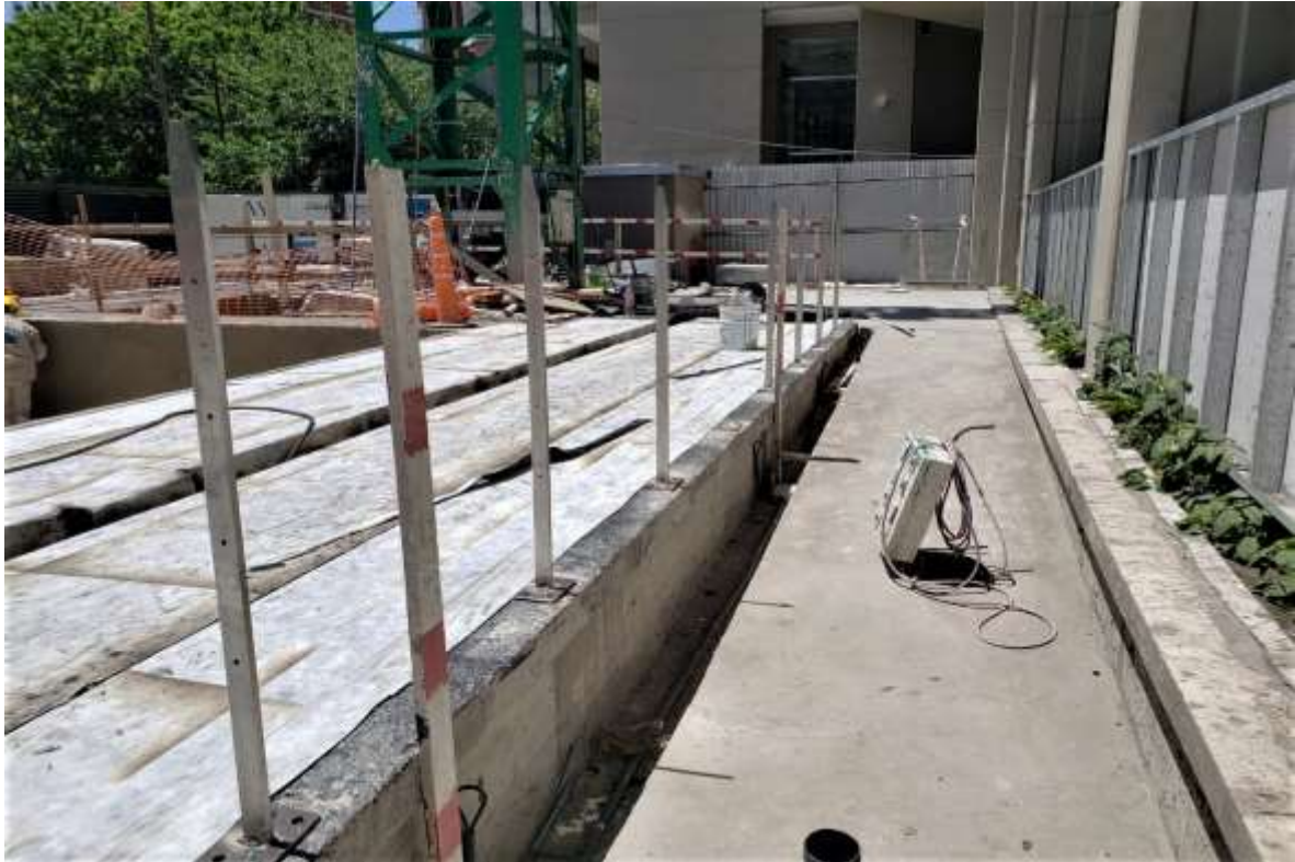
Planta Baja – Colocación Parantes Baranda Pileta
