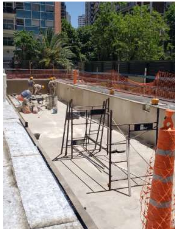
Planta Baja – Revocado Pileta
