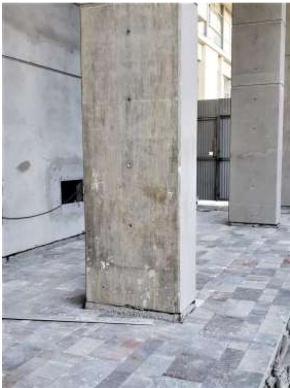
Planta Baja – Colocación Piso Pórfido
