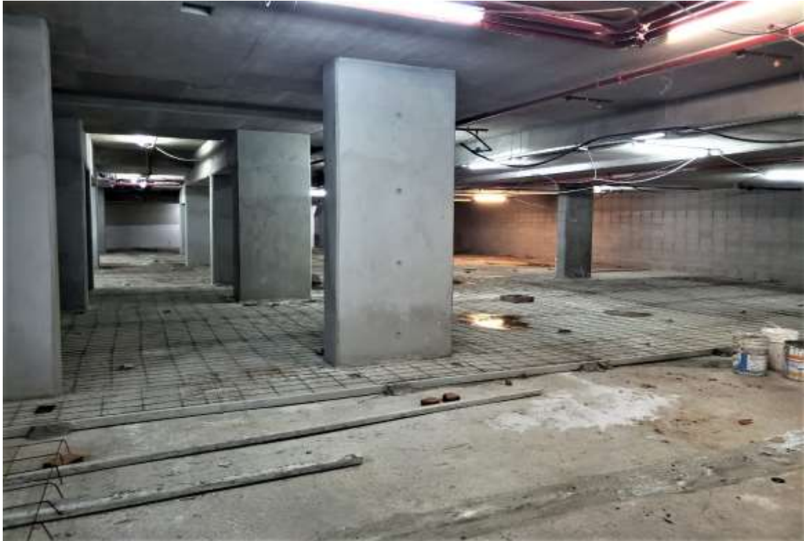
Primer Subsuelo – Piso llaneado 2ª. Etapa
