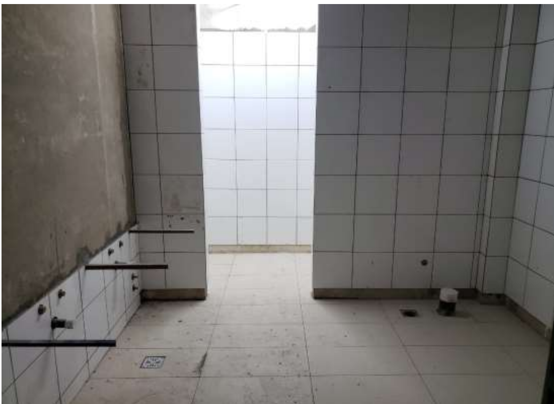
1º. Subsuelo – Colocación en Vestuarios
