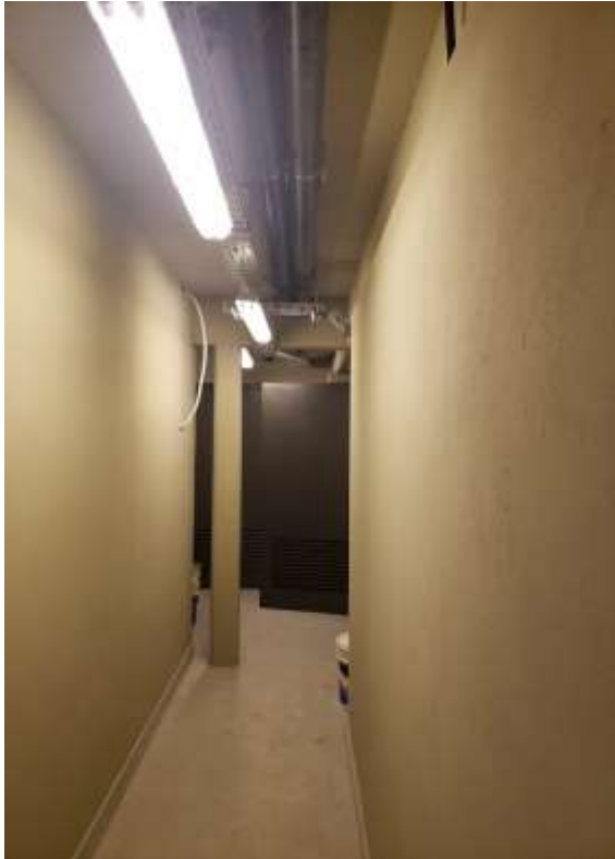
Piso 31°. Pintura Sala de Máquinas
