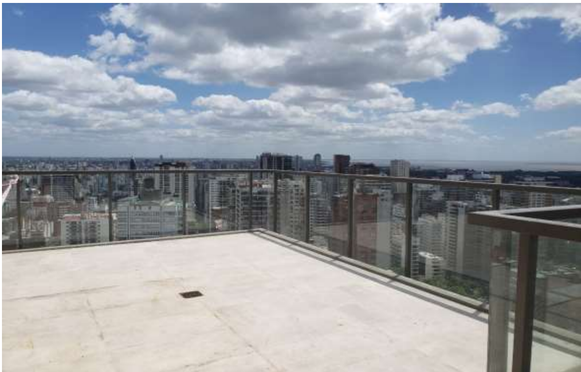
Piso 31°. Montaje de Barandas
