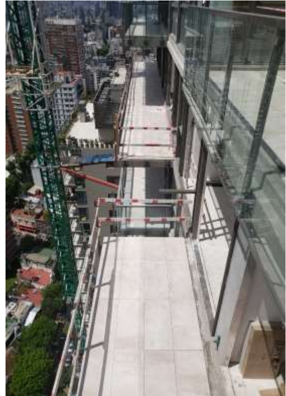
Piso 30°. Retiro de Defensas y Colocaciones
