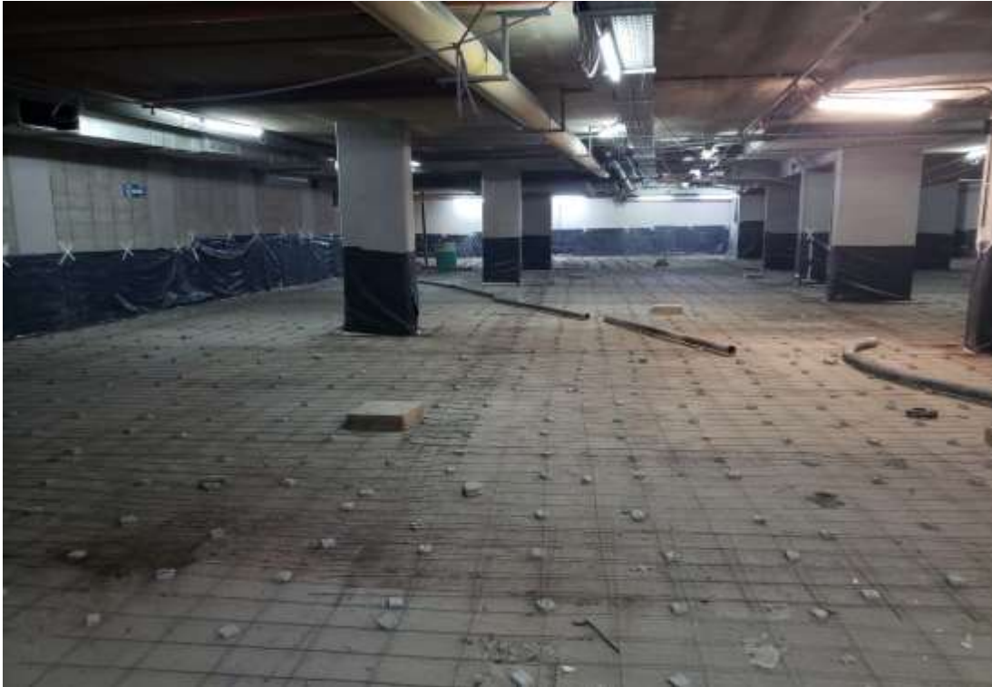
1º. Subsuelo – Tareas previas a llaneado
