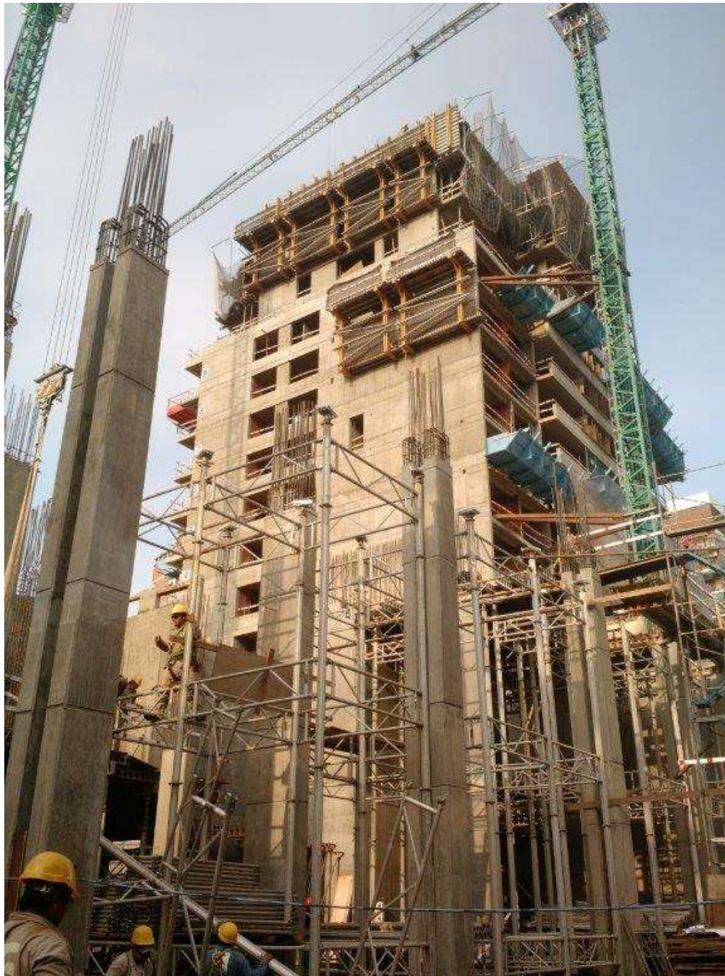
Torres Zabala y Arcos – Avance Estructura Hormigón Armado
