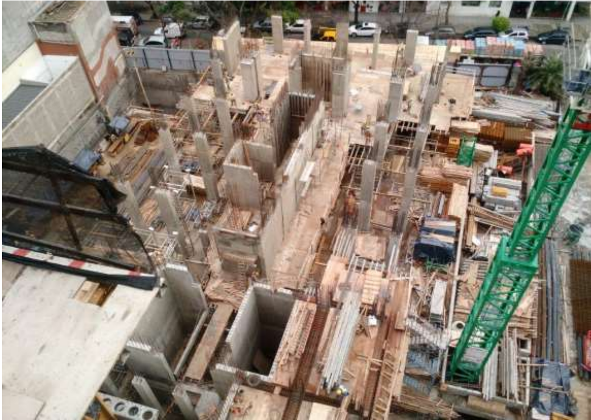
Torre Arcos – Vista aérea encofrado P. Baja
