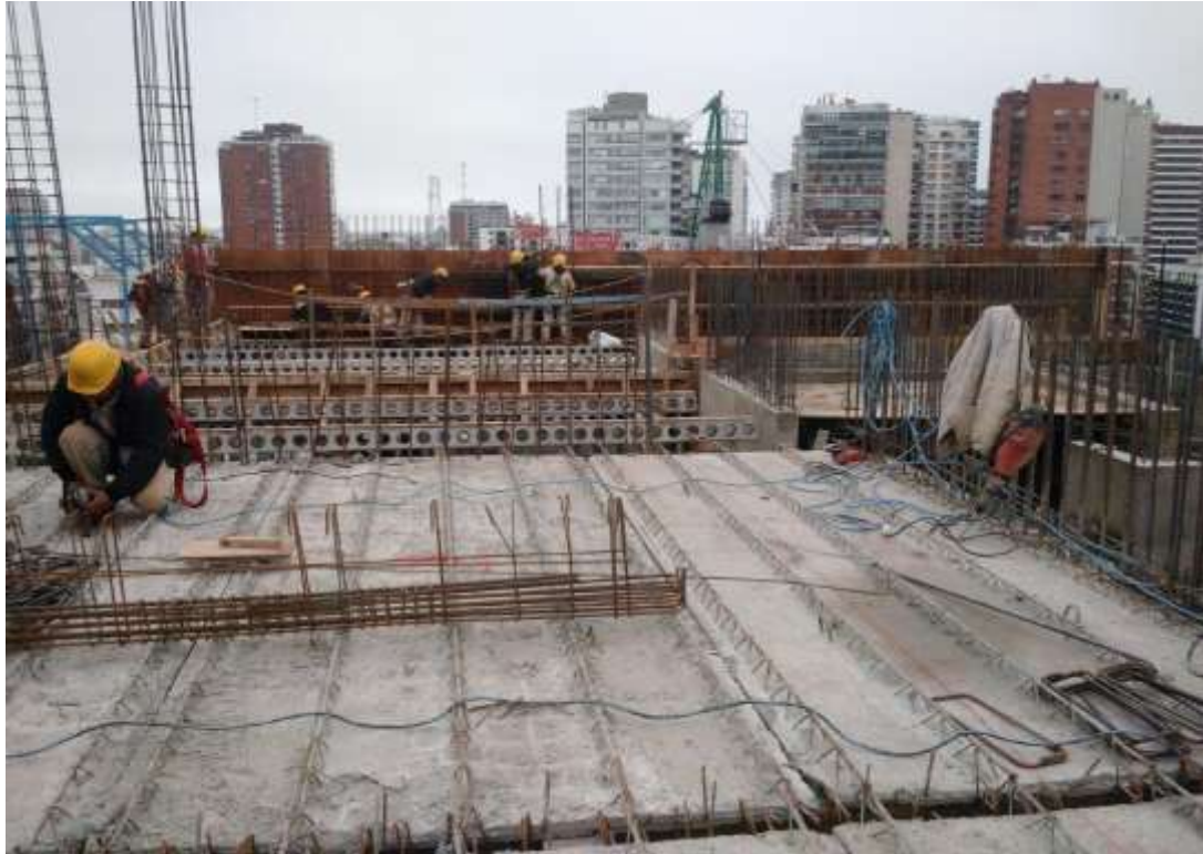
Torre Zabala – Armado losas s/13º.Piso
