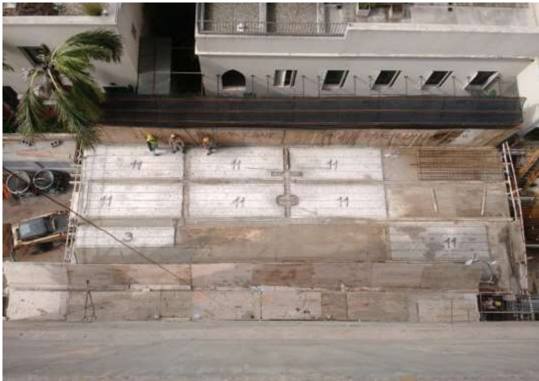
Torre Zabala – Vista aérea hormigonado Prelosas
