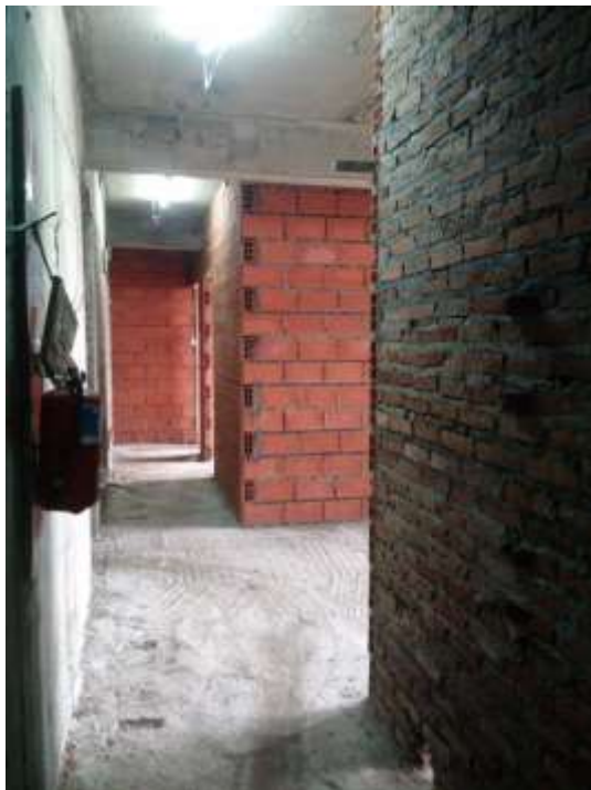
Torre Zabala – Albañilería 10º Piso
