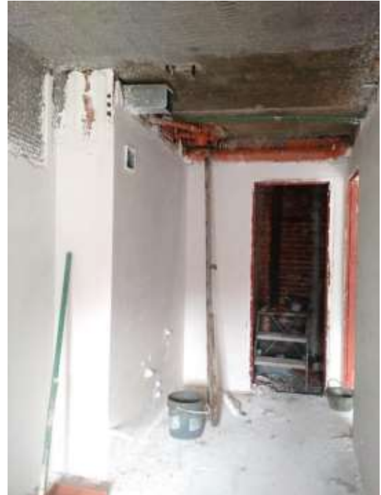
T. Zabala – Ejecución Yeso 3º.Piso
