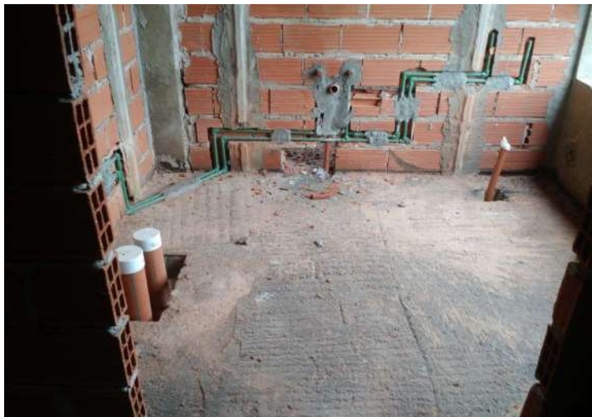
Torre Zabala – Instalación Cloaca y Agua 8º.Piso
