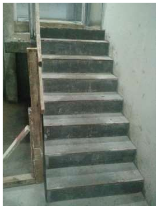
Torre Zabala – Terminación Escalera 4º.SS
