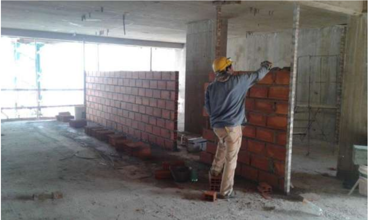
Torre Zabala – Mampostería 3er. Piso
