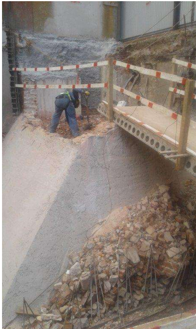
T. Arcos – Demolición Centro de Potencia
