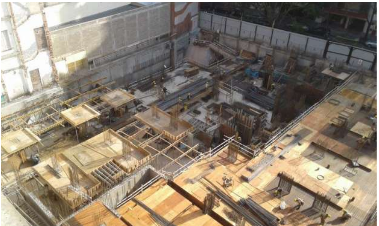
Torre Arcos – Encofrado s/1er. Subsuelo – Contrafrente
