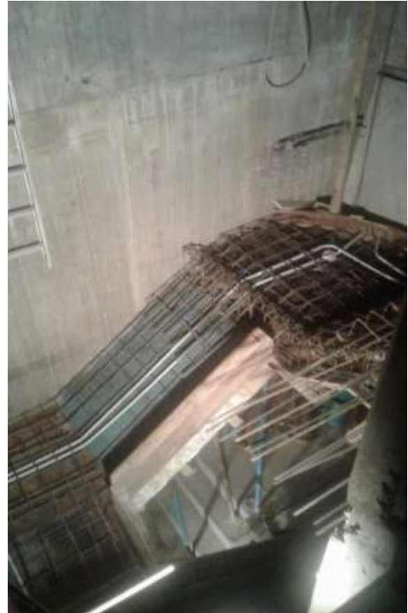
Torre Zabala – Armado Escalera s/P.Baja
