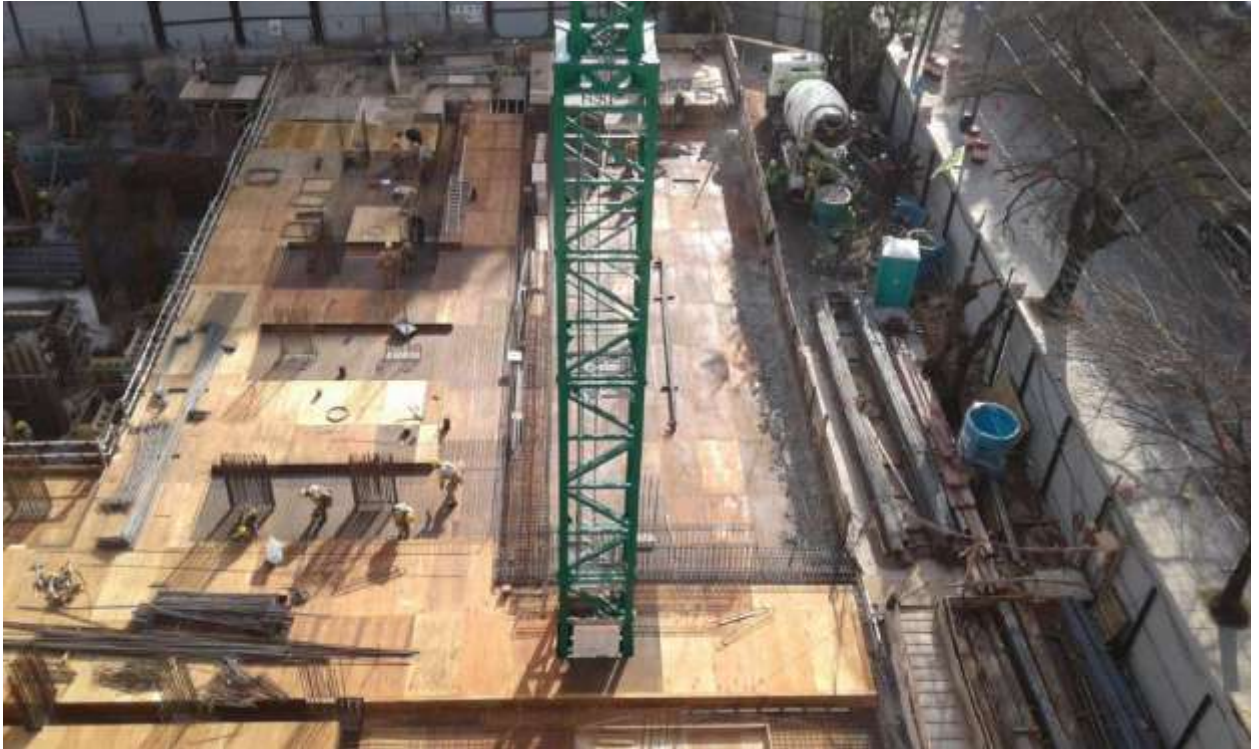
Torre Arcos – Encofrado s/1er. Subsuelo – Frente
