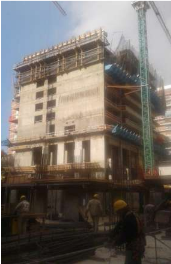
Torre Zabala – Encofrado 7º.Piso
