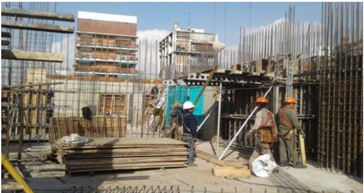
Torre Zabala – Armado columnas 7º.Piso
