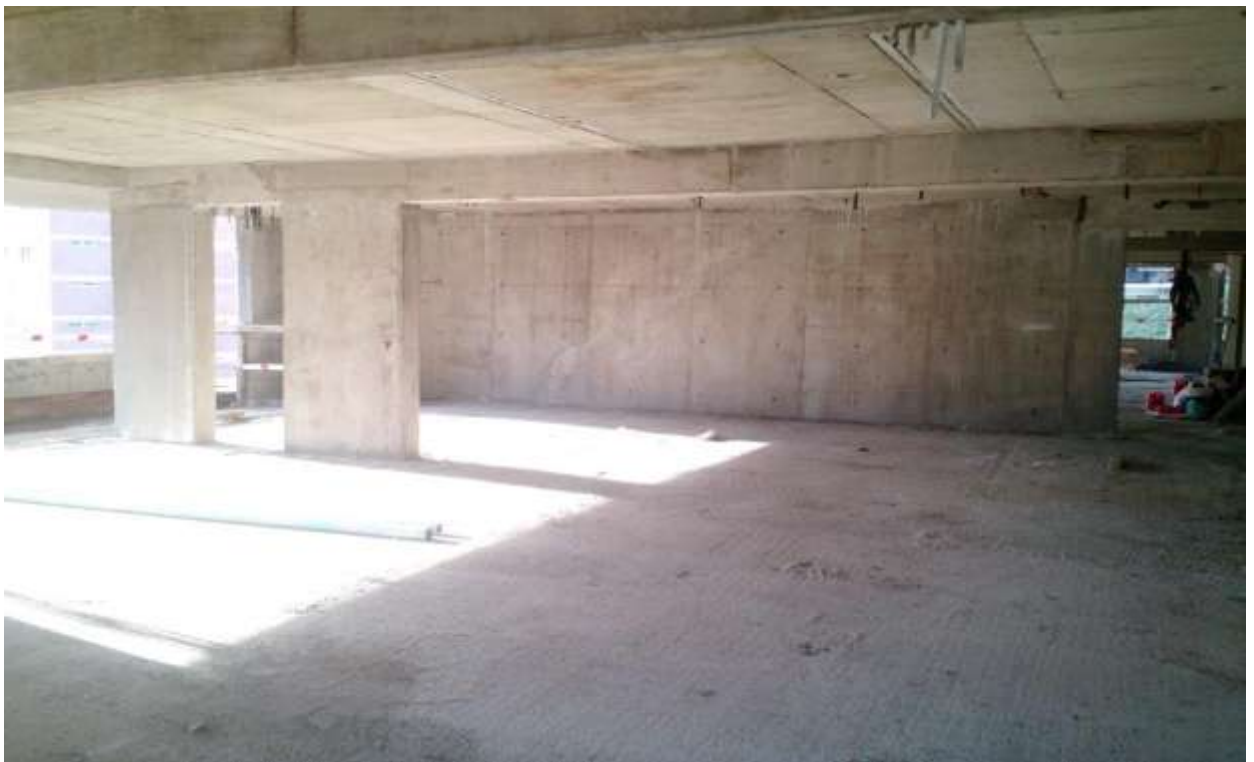
Torre Zabala – Desencofrado 4º.Piso
