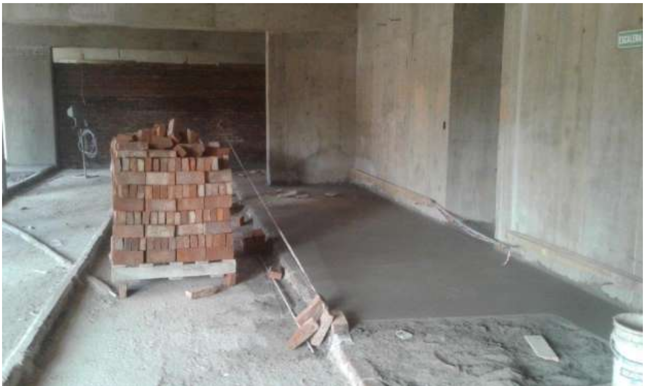
Torre Zabala – Contrapisos en 1er. Piso
