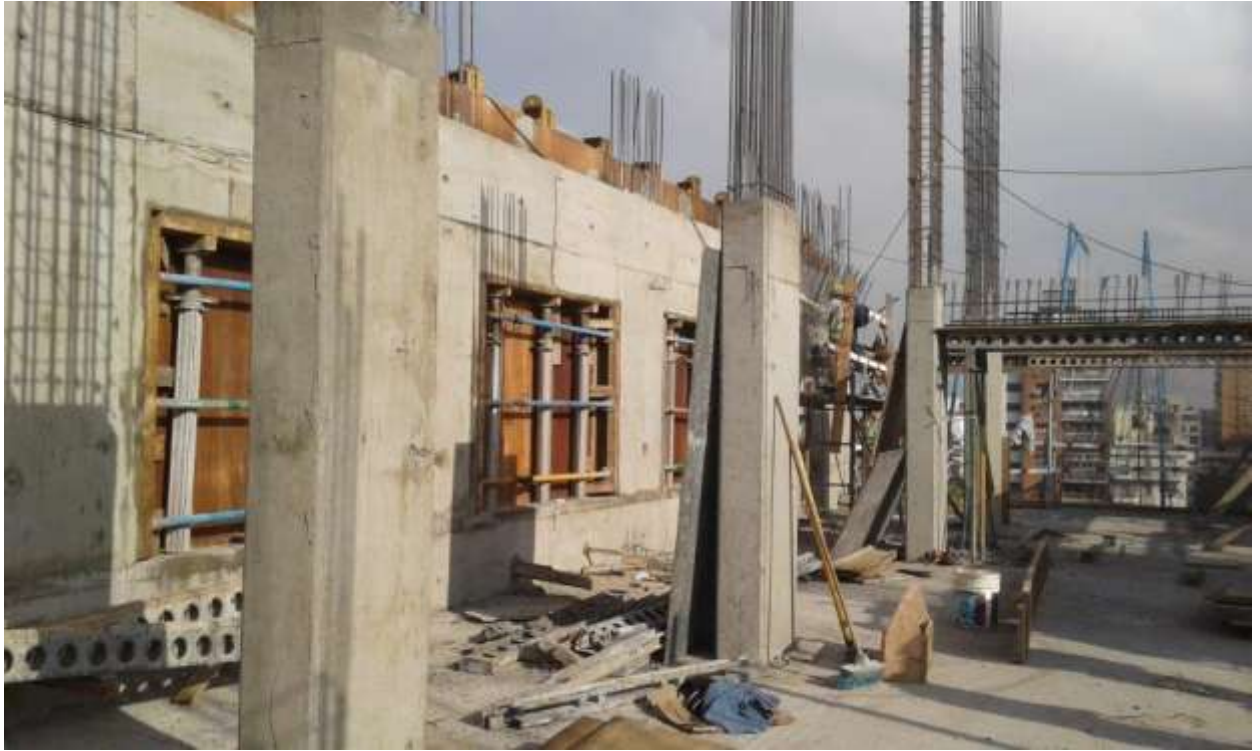
Torre Zabala – Desencofrado Columnas
