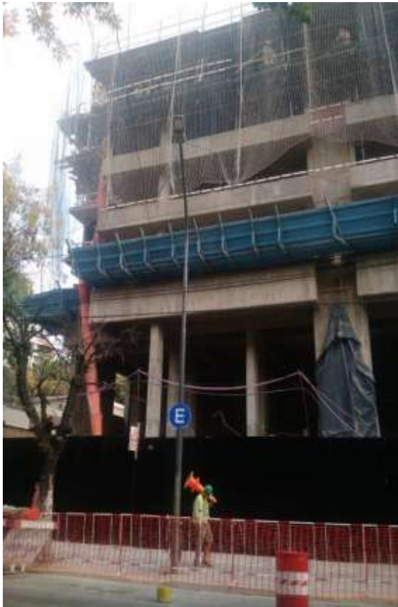
Torre Zabala – Avance Estructura s/5º. Piso
