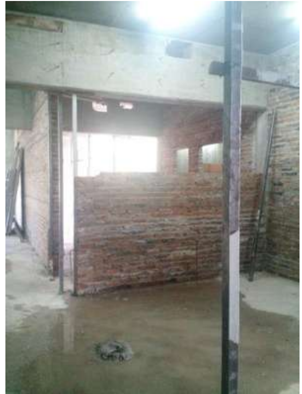
Torre Zabala – Albañilería 1º. Piso
