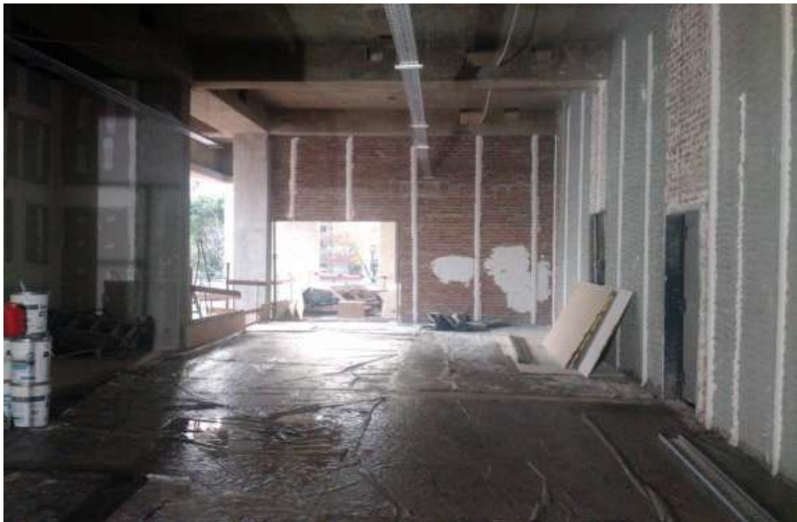
Torre Zabala – Albañilería e Instalación Eléctrica Entrepiso
