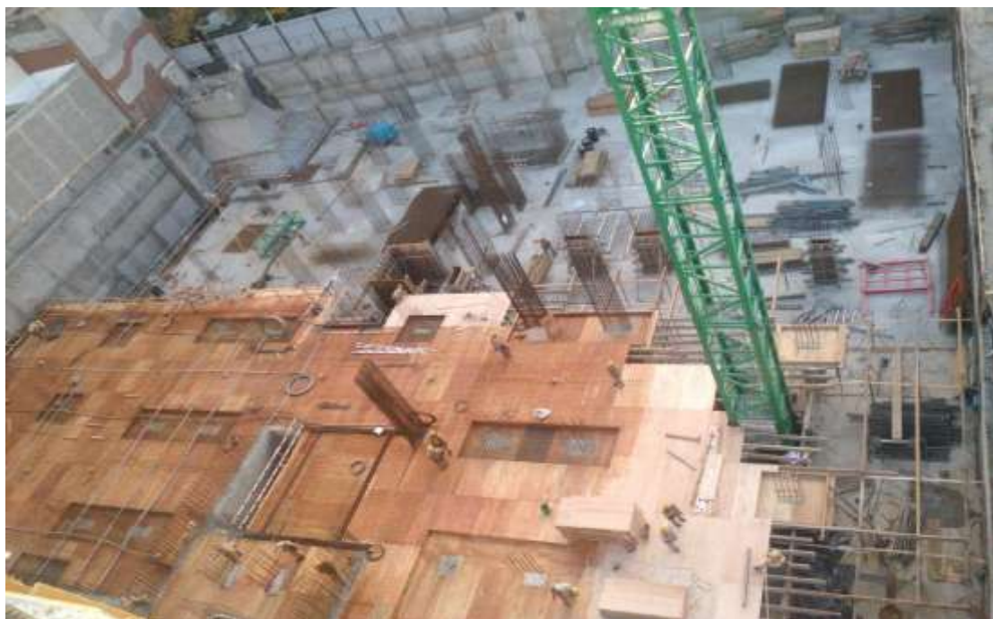
Torre Arcos – Encofrado y armadura s/2º. Subsuelo
