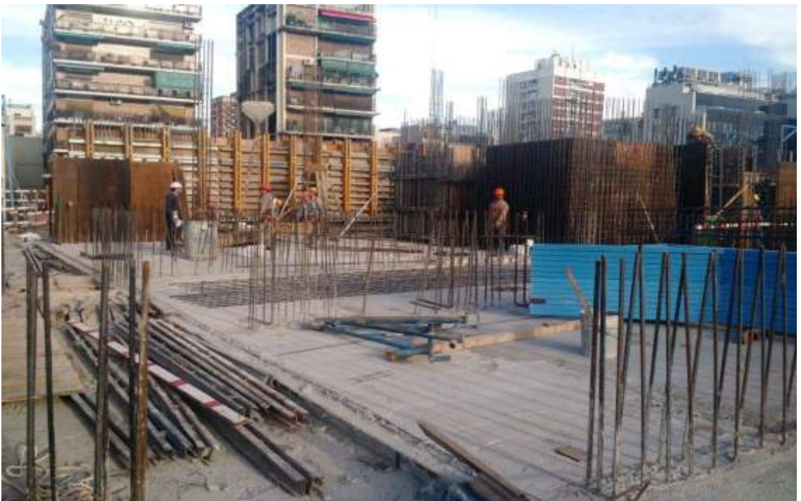
Torre Zabala – Armado Columnas 5º.Piso
