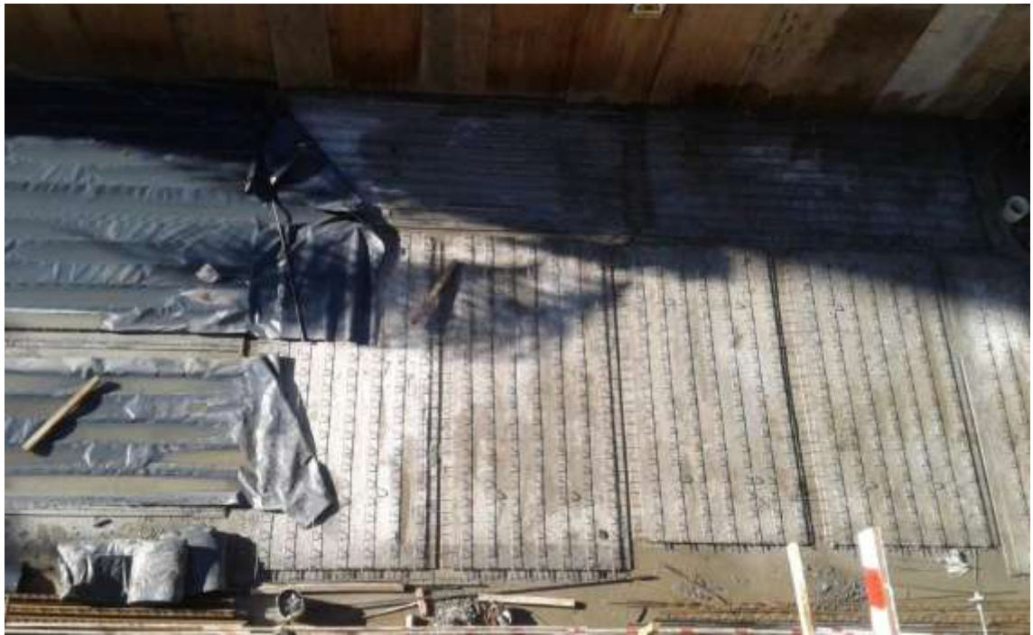
Torre Zabala – Fabricación Prelosas
