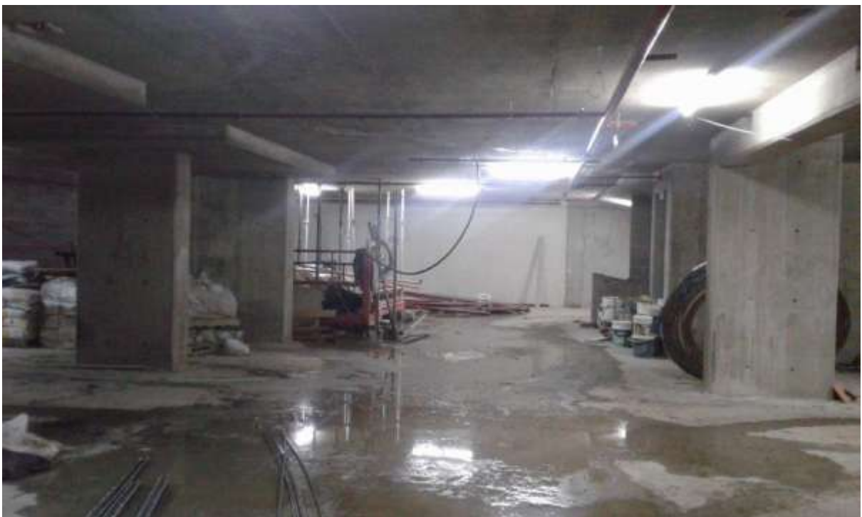
Torre Zabala – Instalación Extinción de Incendio en Subsuelos
