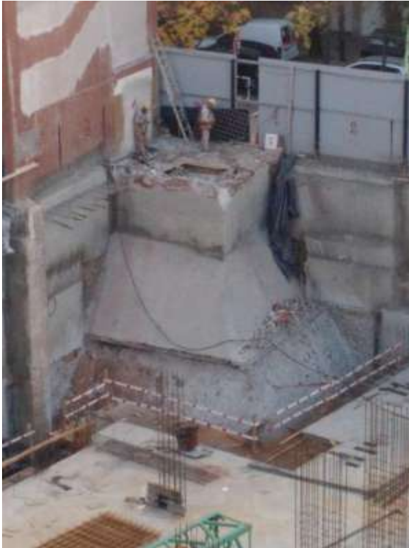
Torre Arcos – Demolición Centro de Potencia
