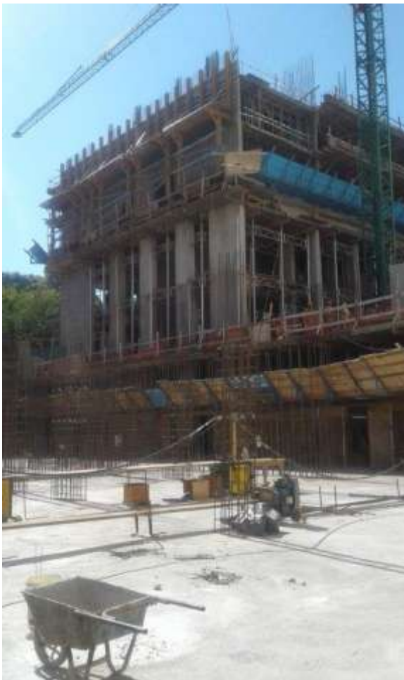
Torre Zabala – Vista Avance Hormigón
