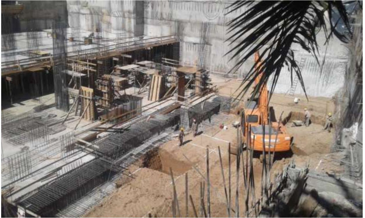
Torre Arcos – Vista General Avance Hormigón
