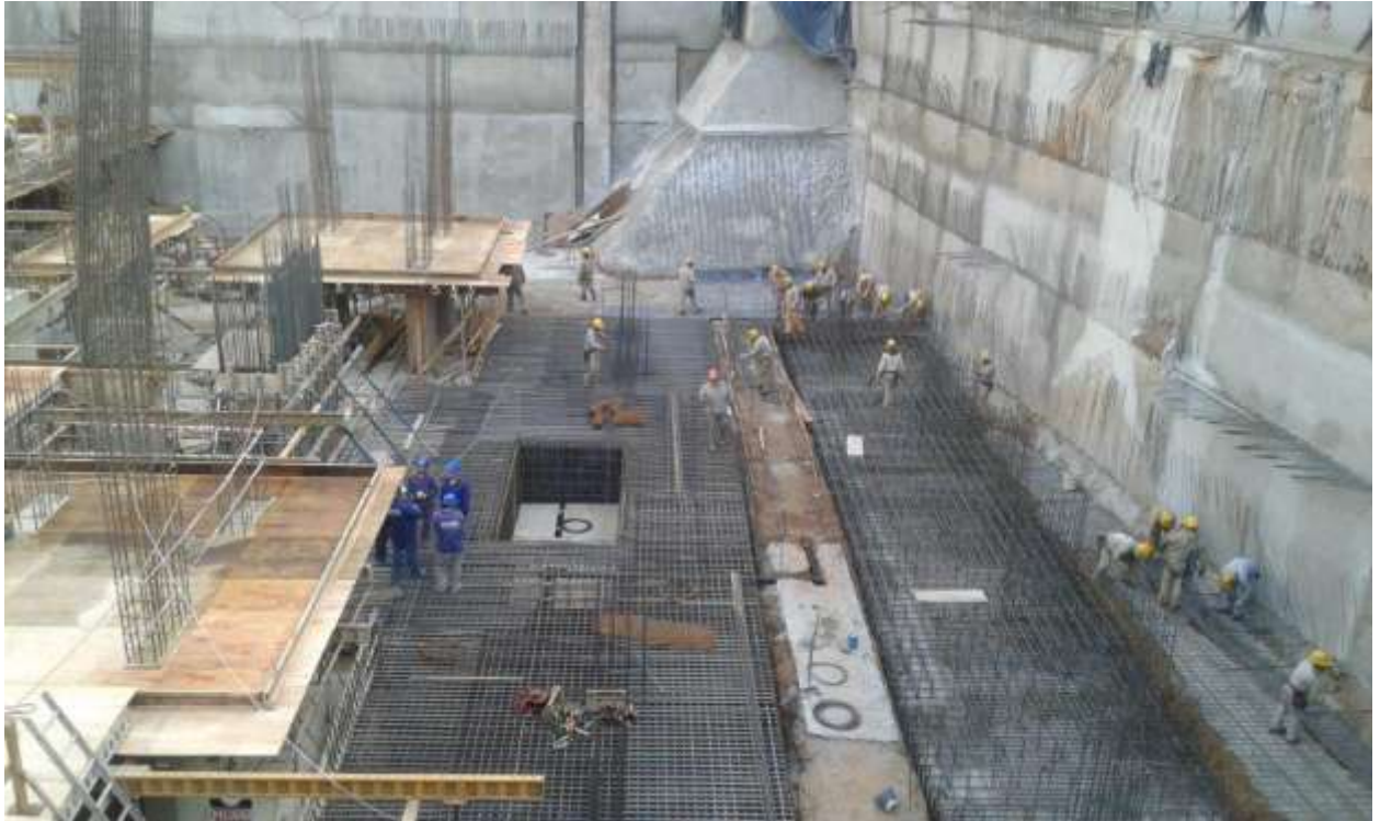
Torre Arcos – Armado Platea s/V.Loreto
