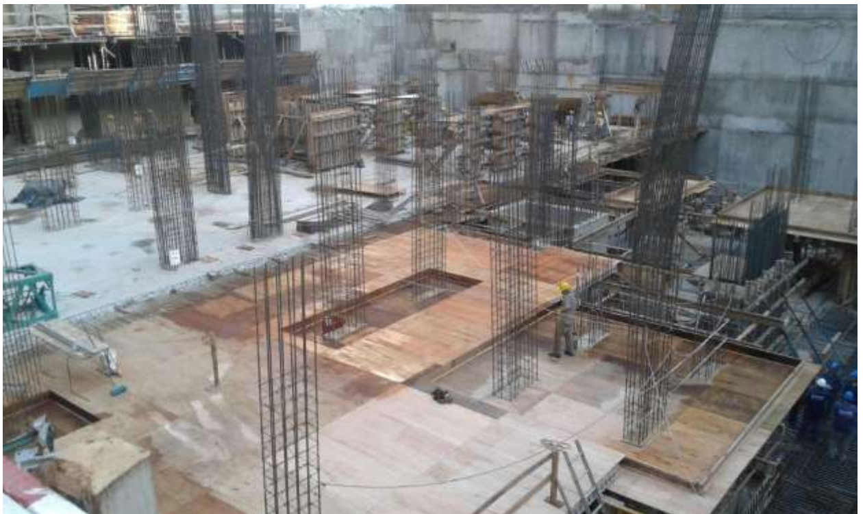
Torre Arcos – Encofrado s/3º.Subsuelo (parcial)
