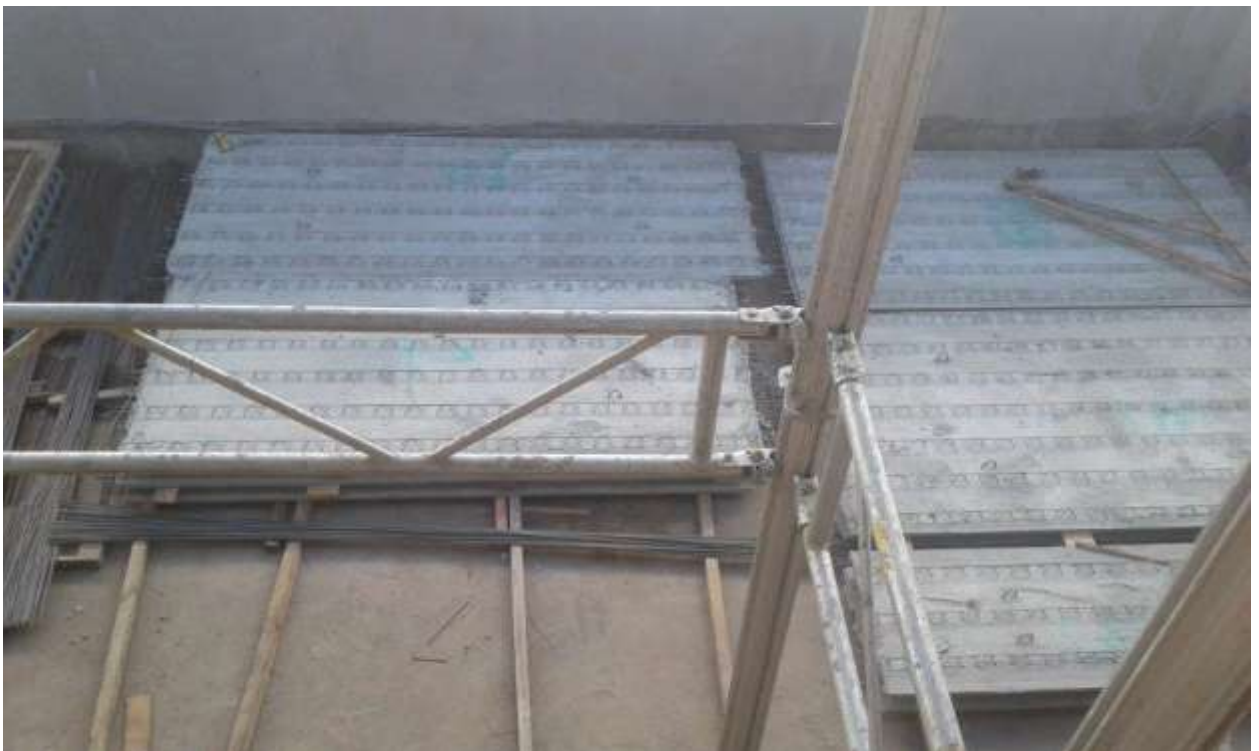
Torre Zabala – Desencofrado de Prelomas
