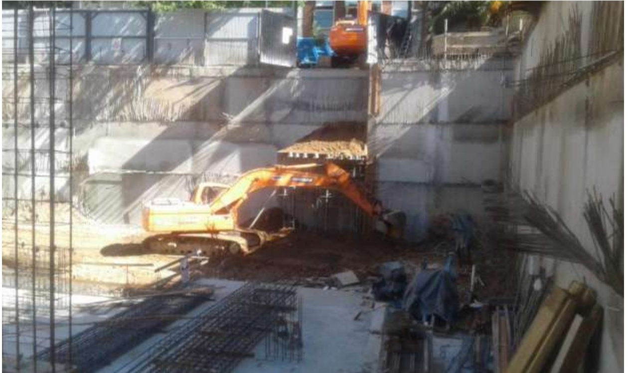
Torre Arcos – Movimiento de Suelos Final
