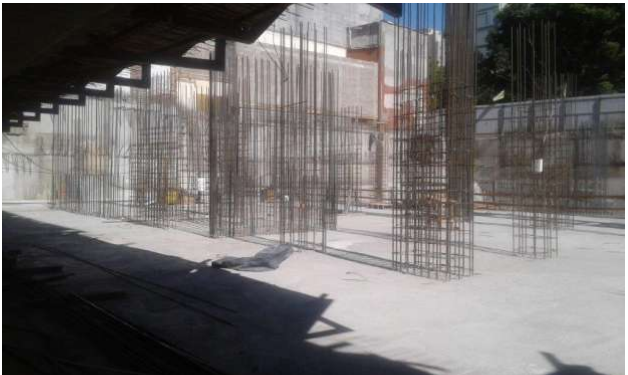
Torre Arcos – Armado Columnas 2°. Subsuelo (parcial)
