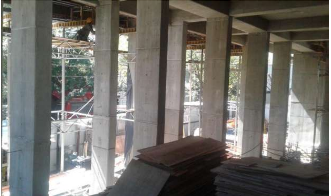
Torre Zabala – Desencofrado Nivel Planta Baja
