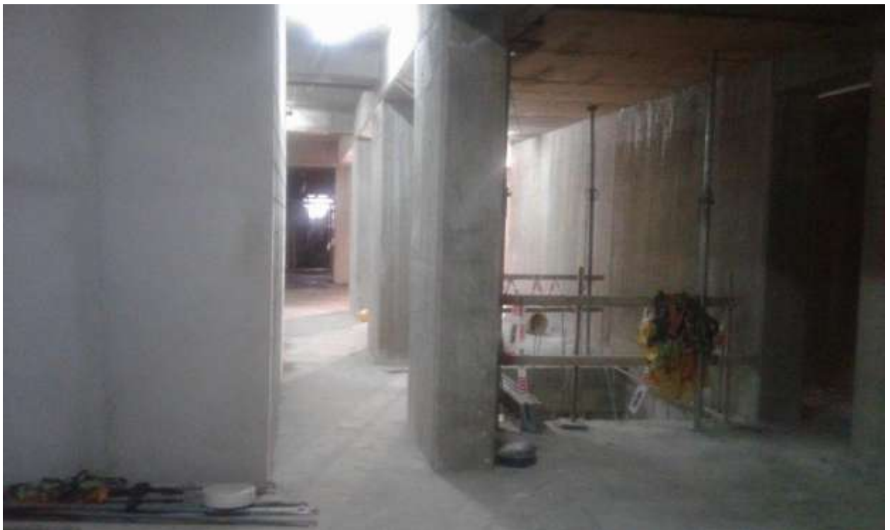
Torre Zabala – Mampostería y Revoques 1er. Subsuelo
