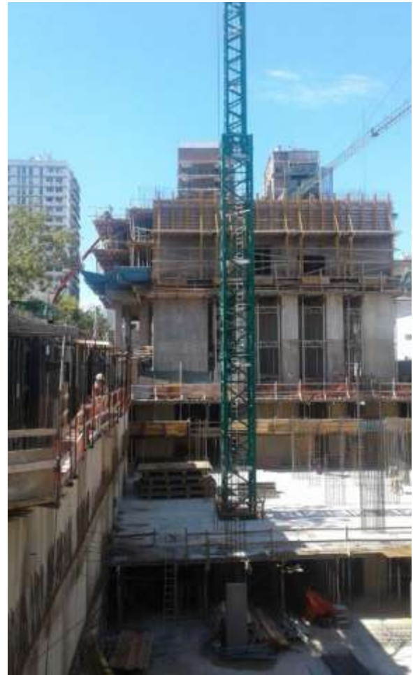
Torre Zabala – Encofrado Trepante Tabique
