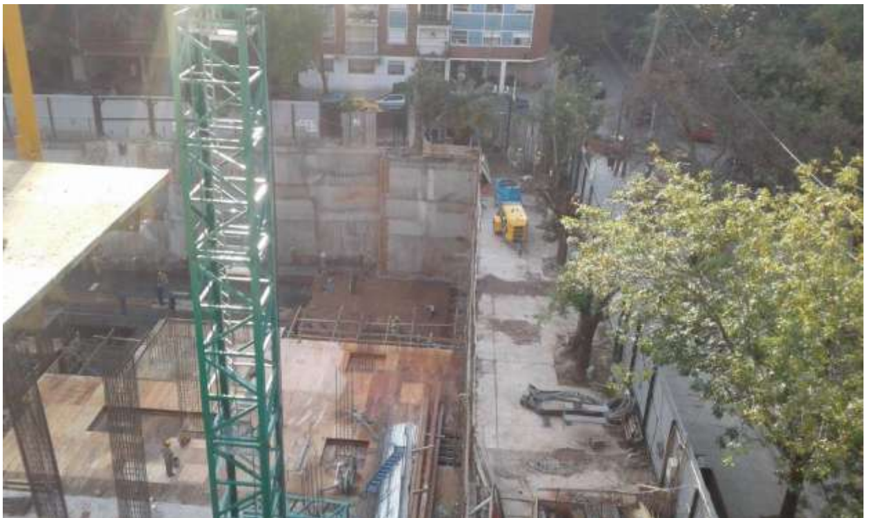
Torre Arcos – Sector para Acceso de Camiones de Ho. Sobre Arcos
