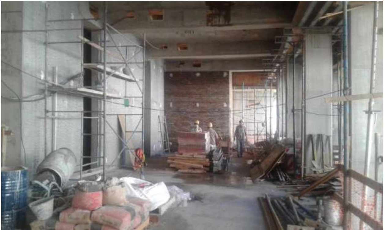
Torre Zabala – Mampostería Entrepiso
